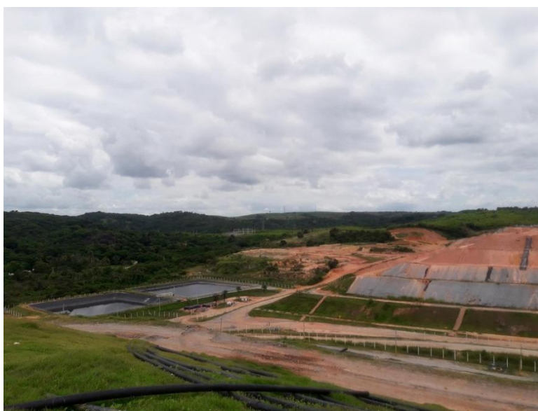
Figura 5 - Lagoas de estabilização para tratamento do chorume no CTR Candeias
