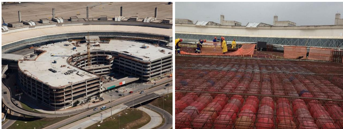
Figura 1 - Edifício Garagem do Galeão
