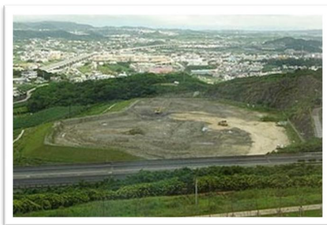
Figura 3 - TERRENO DESTINADO A ATERRO SANITÁRIO - JAPÃO
