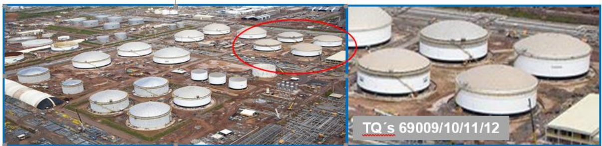
Figura 8 - Vista superior da tancagem de nafta petroquímica
