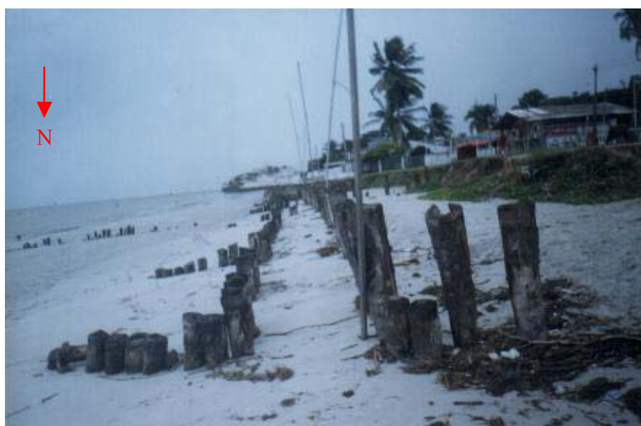
Figura 35 – Detalhe para estruturas de coqueiros colocadas para contenção da erosão
