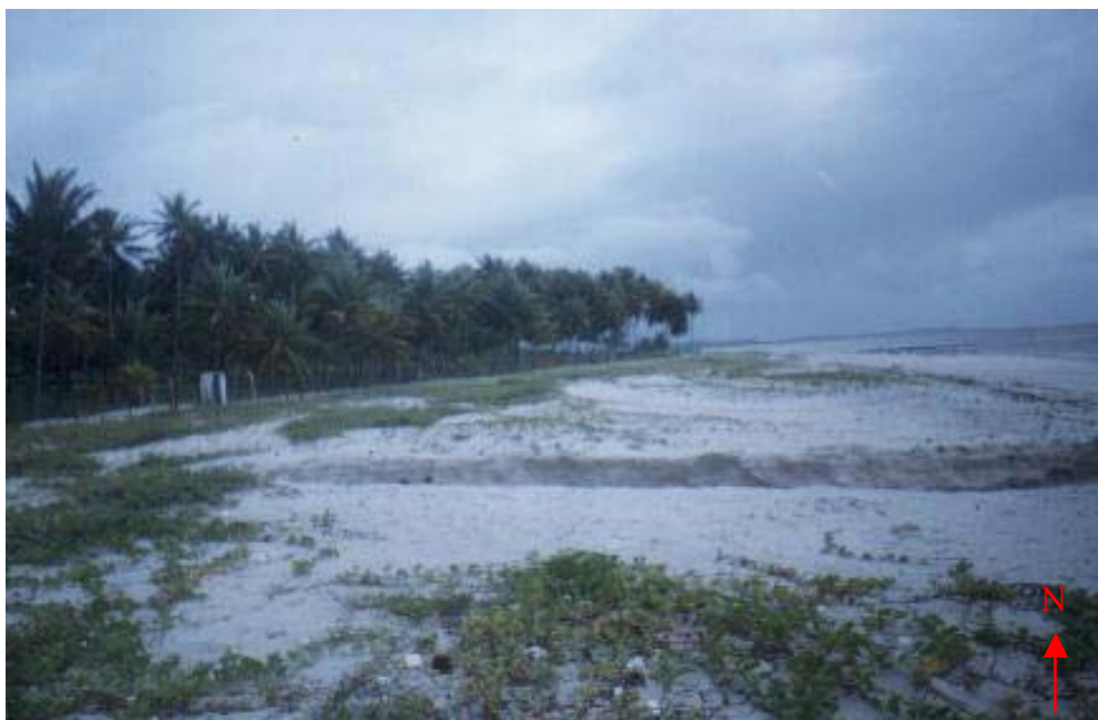
Figura 40 – Praia de Jaguaribe, detalhe para abertura da valeta pela ação das águas fluvial.
