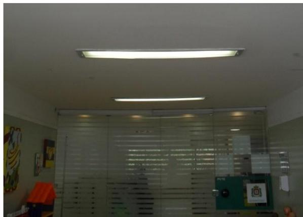
**Figura 3.8 – Lâmpadas fluorescentes embutidas no forro de gesso.
