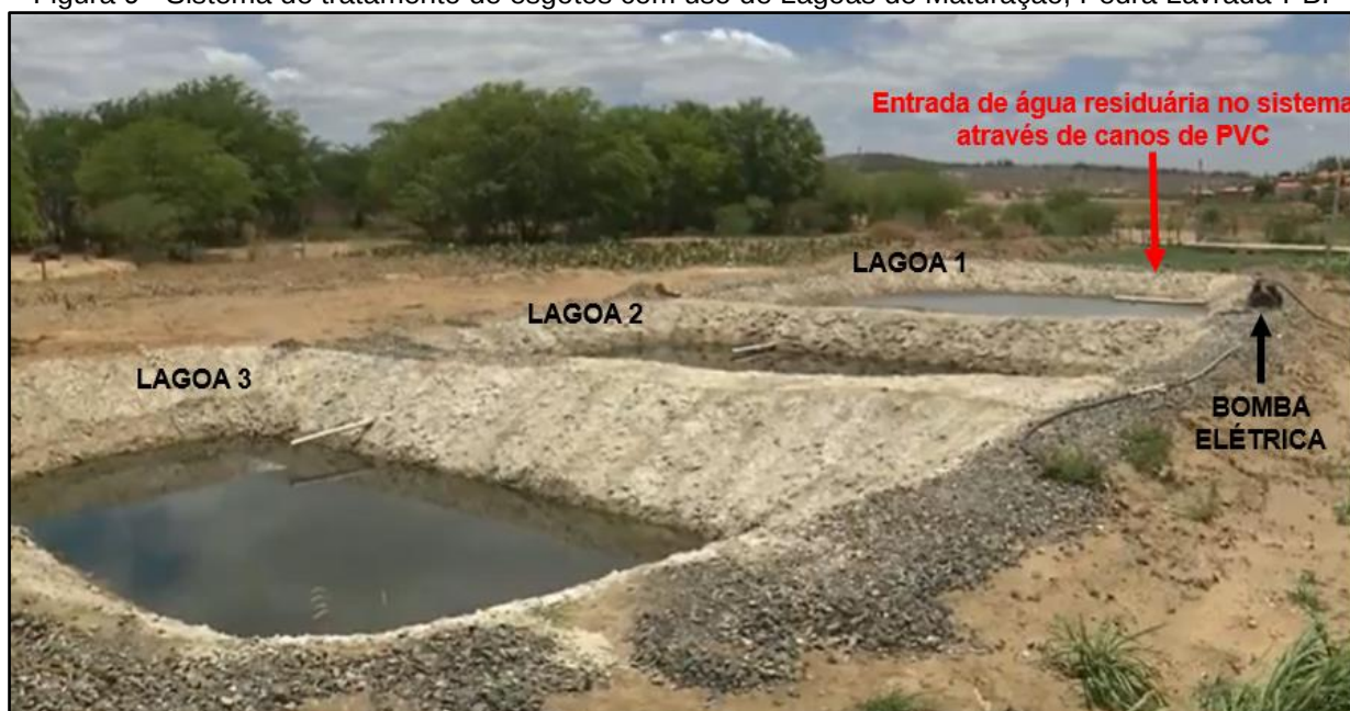
Figura 9 - Sistema de tratamento de esgotos com uso de Lagoas de Maturação, Pedra Lavrada-PB.
