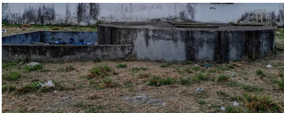
Figura 3: Poço da Estação Elevatória de Esgoto (EEE)
