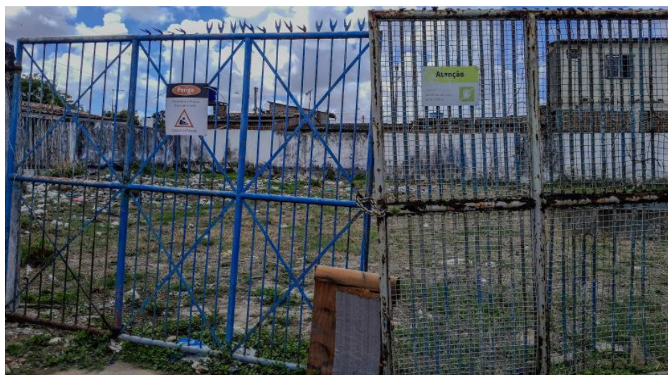
Figura 2: Antiga Estação Elevatória de Esgoto (EEE)
