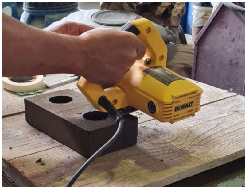
Figura 154 – Corte dos tijolos de solo-cimento.
