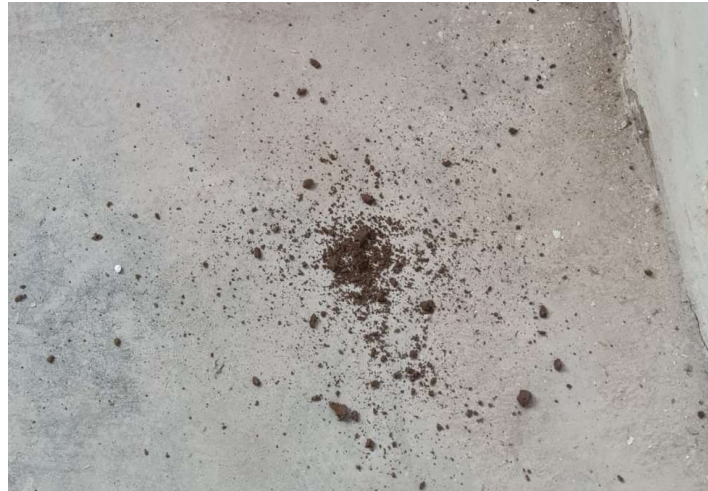
Figura 47 – “Bolo” de mistura solo-cimento esfarelado, como descrito pela ABCP.
