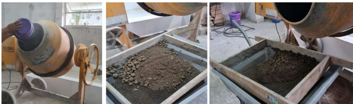
Figura 45 – Mistura em betoneira e peneiramento.
