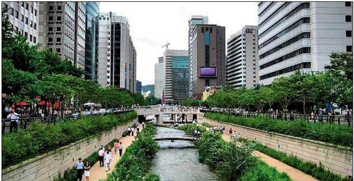
Figura 13 - Requalificação do rio Cheonggyecheon em Seul.
