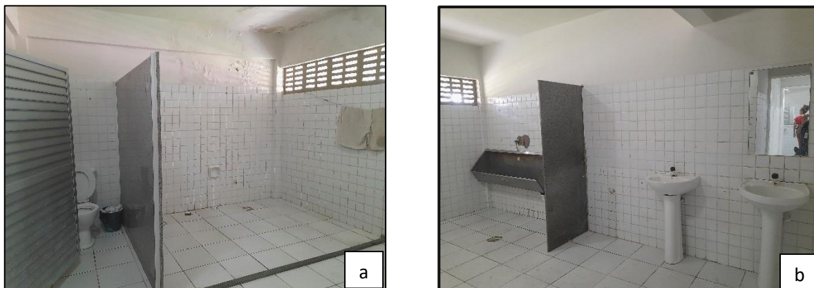
Figura 27 - Instalações sanitárias do Parque Caiara a) sanitário feminino e b) sanitário masculino.
