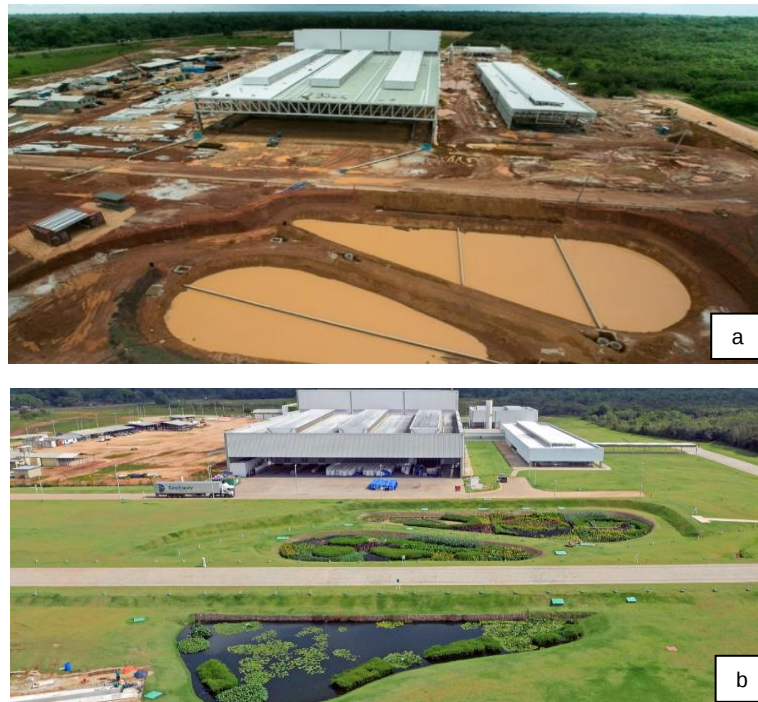
Figura 2 - Wetland construída para tratamento de efluentes industriais e sanitários, a) antes e b) depois.
