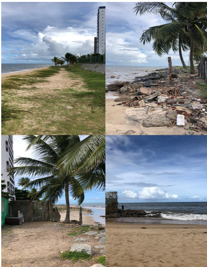
Figura 9 - Desafios Costeiros: Métodos de contenção na faixa de areia impactam a logística, dificultando o acesso das pessoas. O avanço do mar apresenta desafios adicionais para os moradores
