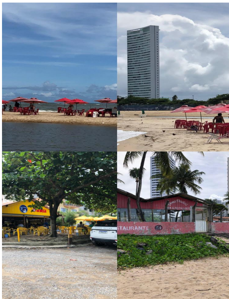
Figura 13 - O mar, em um vai e vem sem fim, escreve sua história nas areias de Jaboatão dos Guararapes. Mas essa história não é só poesia, é dor e desafio. Aqui, bares e barracas são personagens marcados pela erosão costeira, mostrando que proteger nossas praias
