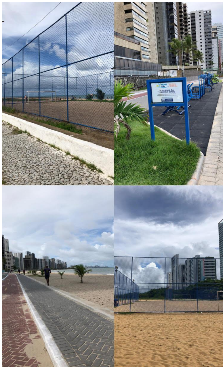
Figura 10 - O avanço implacável do mar: testemunhas mudas da erosão costeira. Estruturas de lazer e infraestruturas recreativas agora vulneráveis, à mercê das águas vorazes. Uma cena que ecoa os impactos visíveis e invisíveis do desafio crescente que enfrentamos
