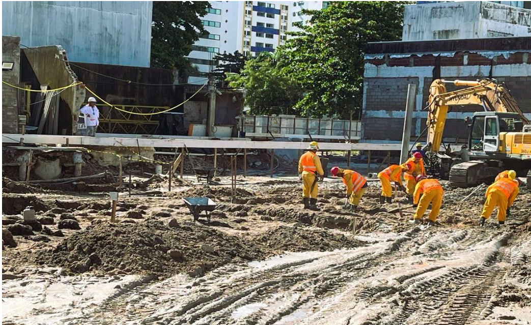
Figura 30 – Solo com melhoramento executado
