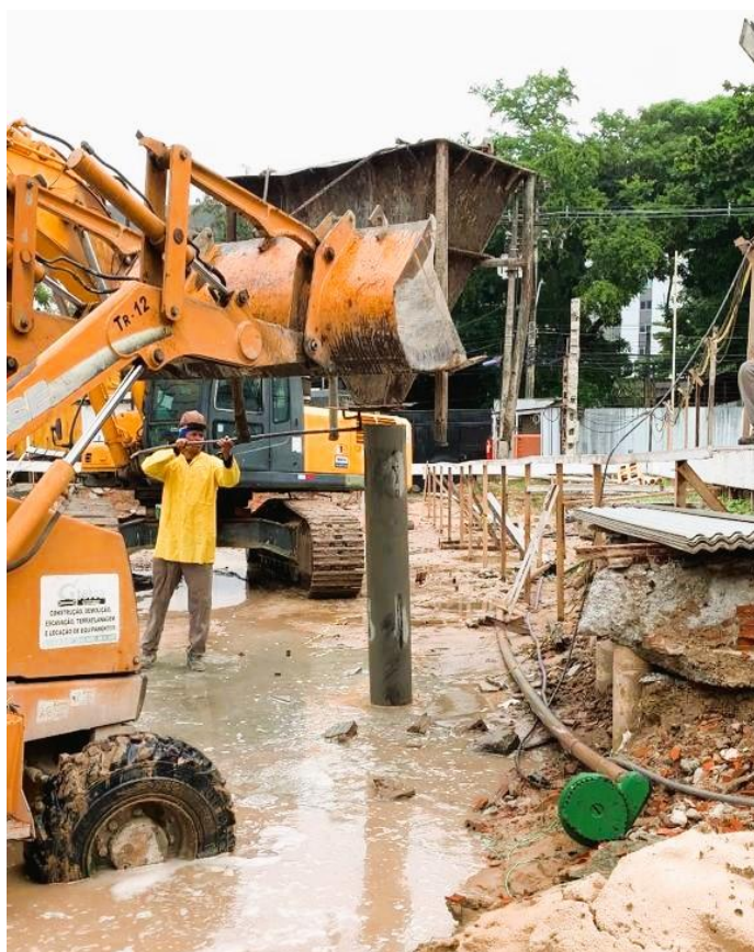
Figura 29 - Lançamento de argamassa através do funil no tubo metálico
