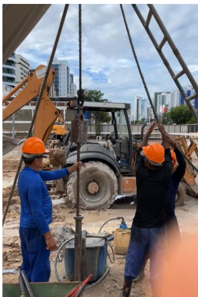
Figura 20 – Ensaio SPT
