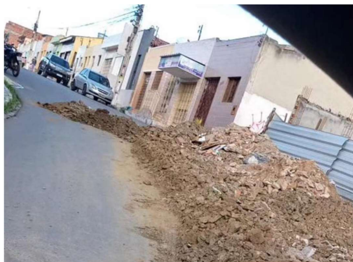
Figura 11 - Obstrução de avenidas por RCC
