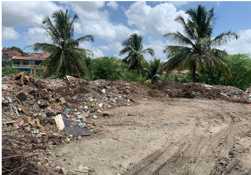
Figura 14 - Trecho recuado para manejo de RCC no bota-fora
