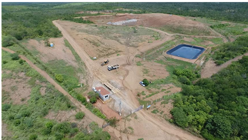
Figura 46 - Aterro sanitário de Salgueiro.
