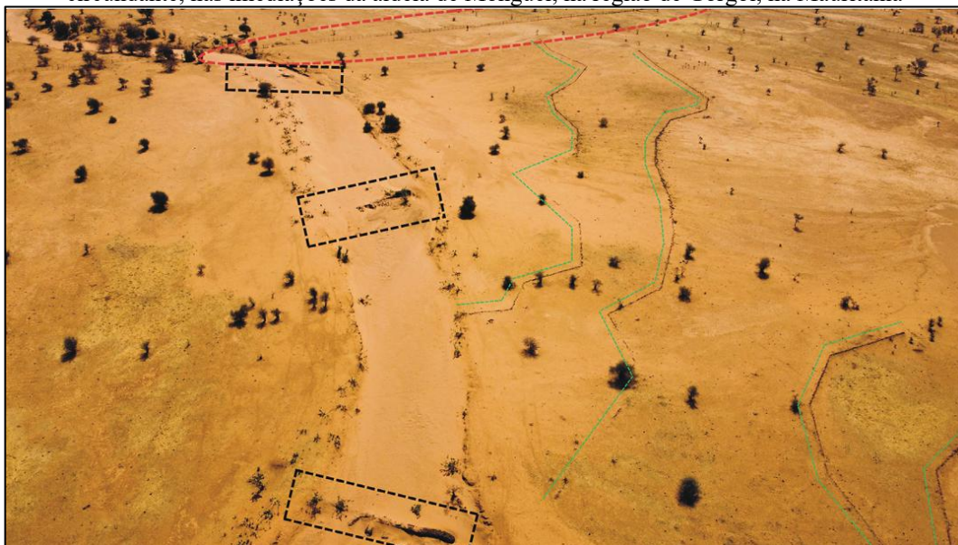
Figura 14 - Delimitações de áreas para instalação de gabiões no leito do rio e na planície de inundação circundante, nas imediações da aldeia de Monguel, na região de Gorgol, na Mauritânia
