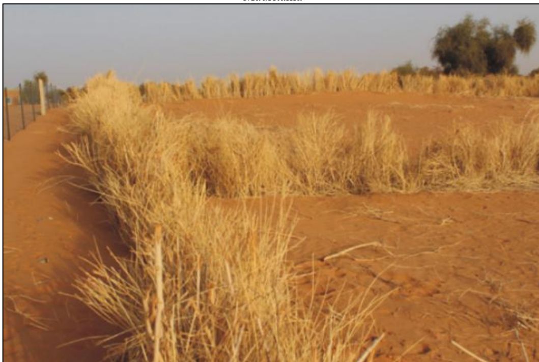
Figura 10 - Fixação de dunas de areia, em Oveivga (região de Trarza) e Toumilla (região de Brakna), na Mauritânia
