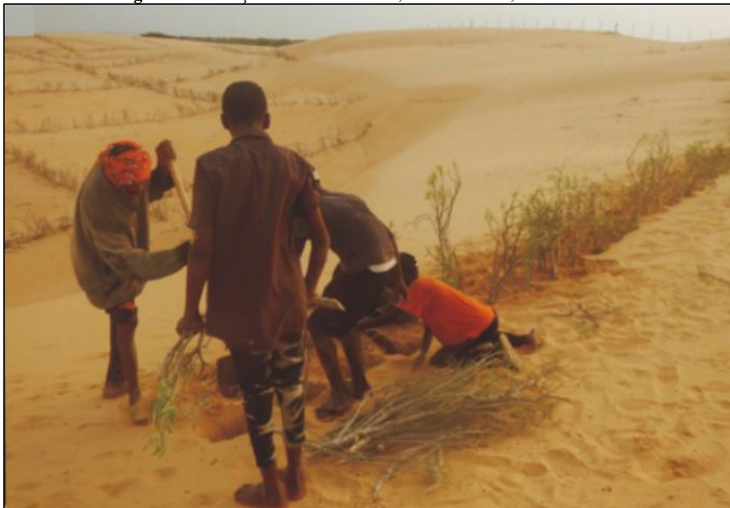
Figura 12 - Fixação de dunas de areia, em Boutilimit, na Mauritânia
