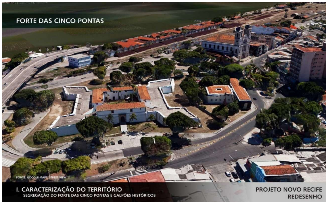
Figura 6 – Imagem aérea do Forte das Cinco Pontas em 2014
