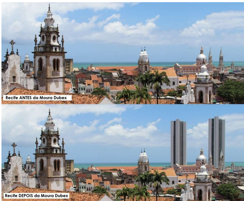
Figura 5 – Imagem aérea das torres das igrejas do Bairro de São José antes e depois da construção dos edifícios píer Maurício de Nassau e Duarte Coelho ao fundo
