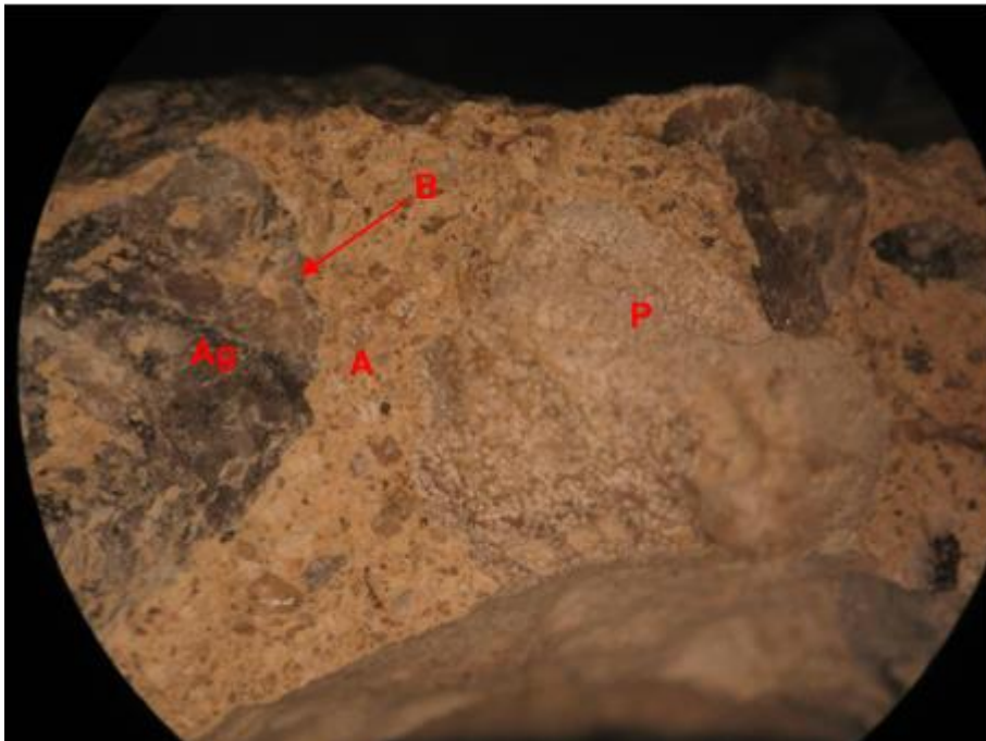
Figura 13– Aspecto geral do concreto. Observa-se material neoformado sobre o agregado (Ag), nos poros (P), na borda (B) e na argamassa (A). Lupa estereoscópica, aumento 36x.
