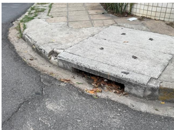
Figura 3: Boca de Lobo simples localizada em via urbana.
