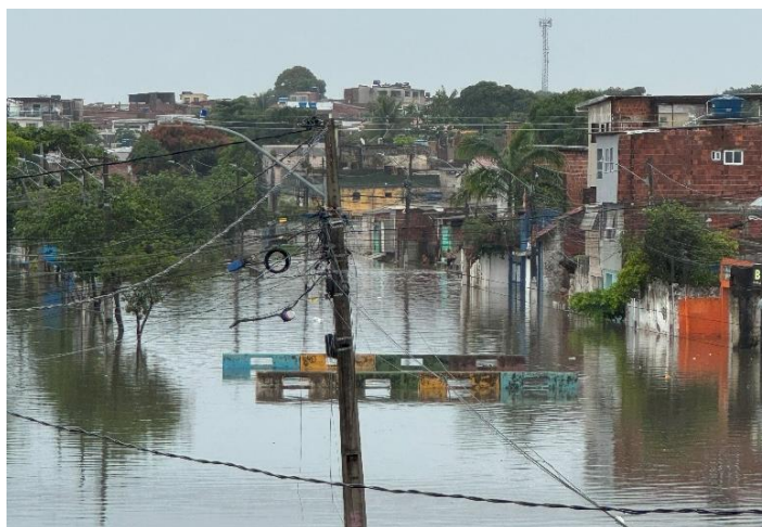
Figura 24: Canal Guarulhos inundado, receptor da vazão do riacho Avenida 30 de Outubro – 05/02/2025.
