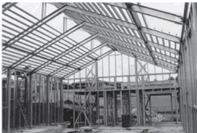
Figura 19 - Estrutura de cobertura inclinada com caibros.
