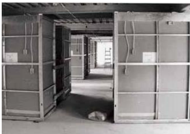
Figura 7 - Módulos de banheiros prontos em Light Steel Frame
