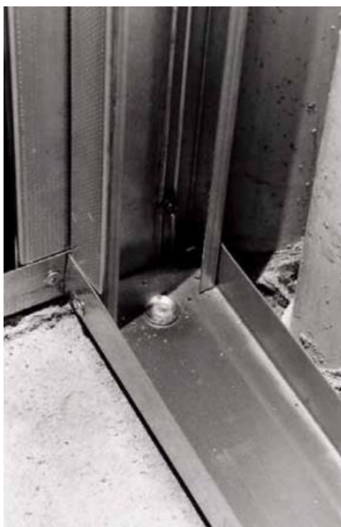
Figura 12 - Ancoragem provisória das guias na fundação
