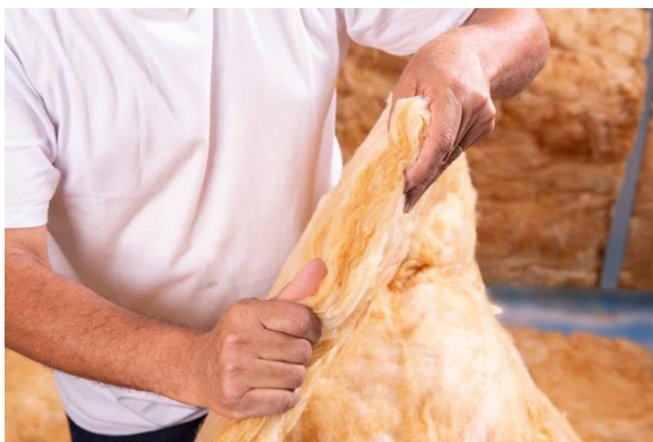
Figura 23 - Isolamento termoacústico em lã de vidro.
