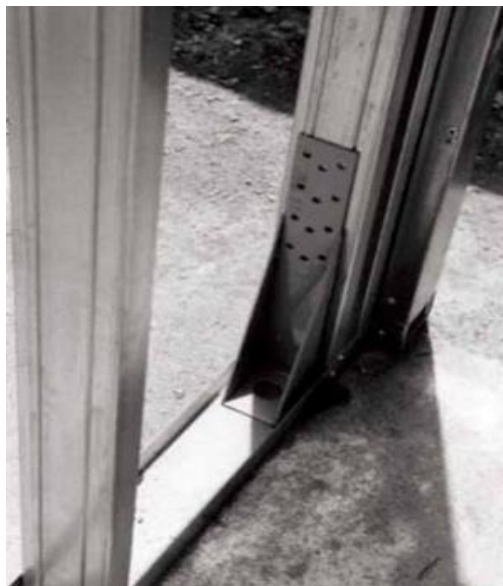
Figura 11 - Início de ancoragem definitiva com perfis duplos.
