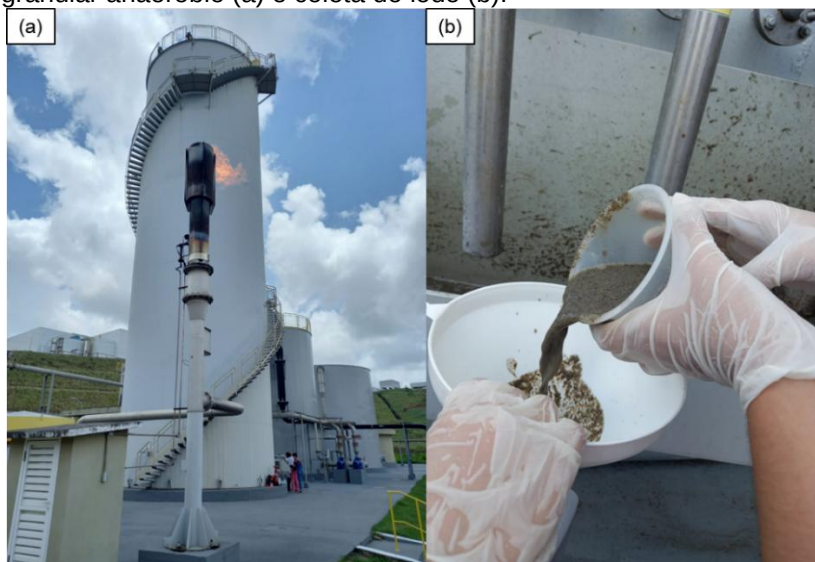
Figura 8 - Reator BIOPAQ®IC utilizado para obtenção do lodo granular anaeróbico (a) e coleta do lodo (b).
