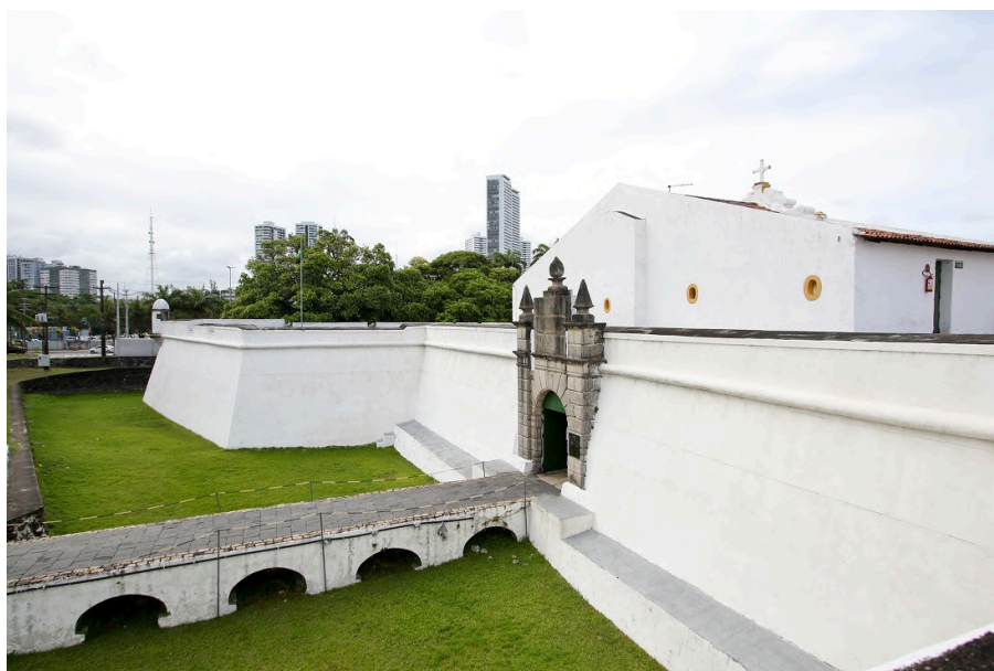
Figura 36: Vista panorâmica da estrutura do Forte do Brum.
