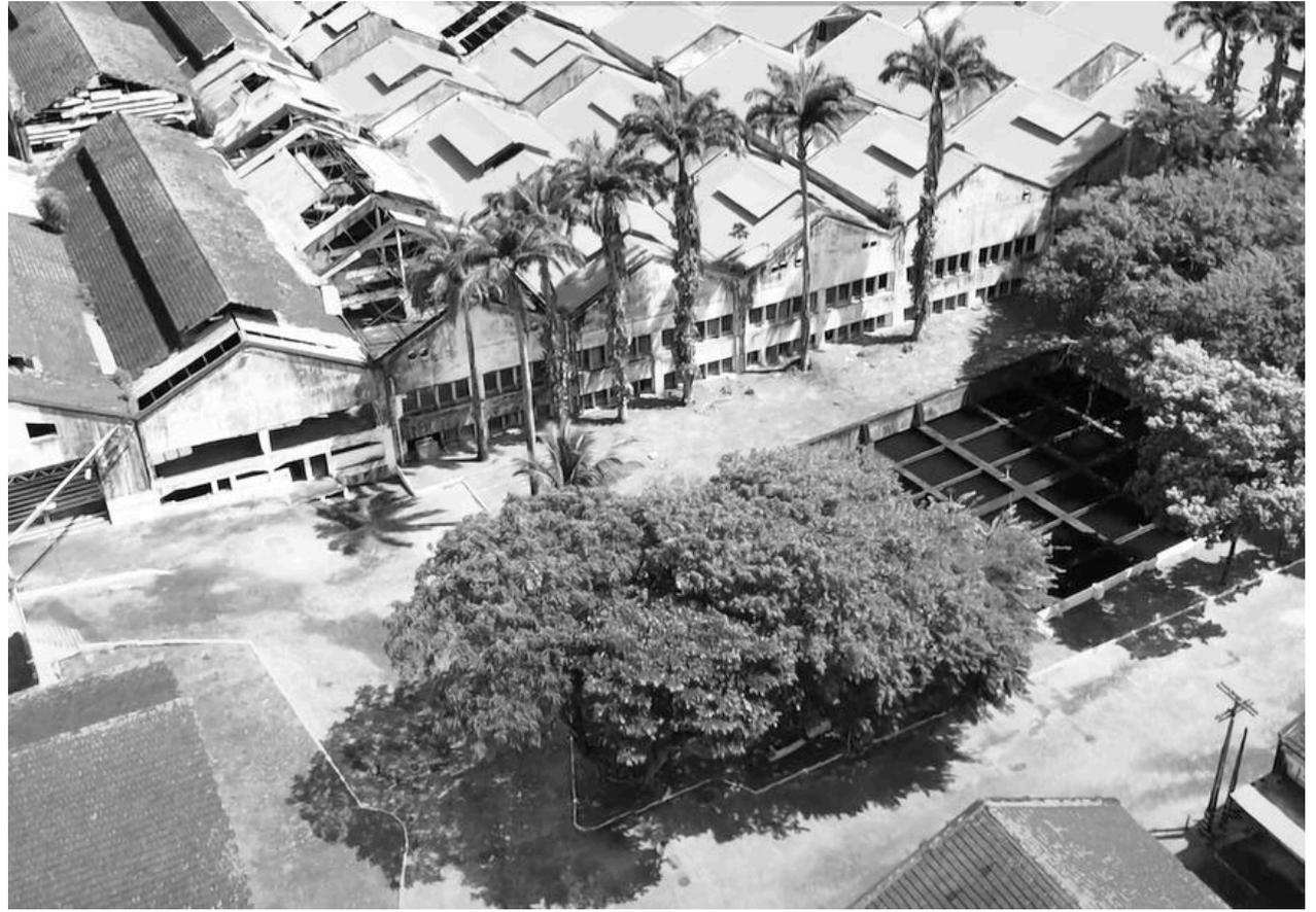
(F78) Vista aérea do Cotonifício - Galpões de Acabamento. Nota-se o destelhamento da cobertura, com exposição e degradação de sua estrutura, o madeiramento original está ausente e houve substituição do revestimento de telhas cerâmicas francesas por telhas de amianto. Fonte: Autor, 2025.
