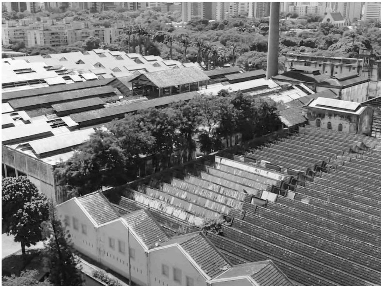
(F76) Vista aérea do Cotonifício - Galpões de Tecelagem (á direita) e Acabamento (á esquerda). Verifica-se o destelhamento de parte da cobertura e substituição do revestimento, há presença de vegetação arbórea no interior dos galpões, crosta negra e descolamento do reboco nas paredes. Fonte: Autor, 2025.
