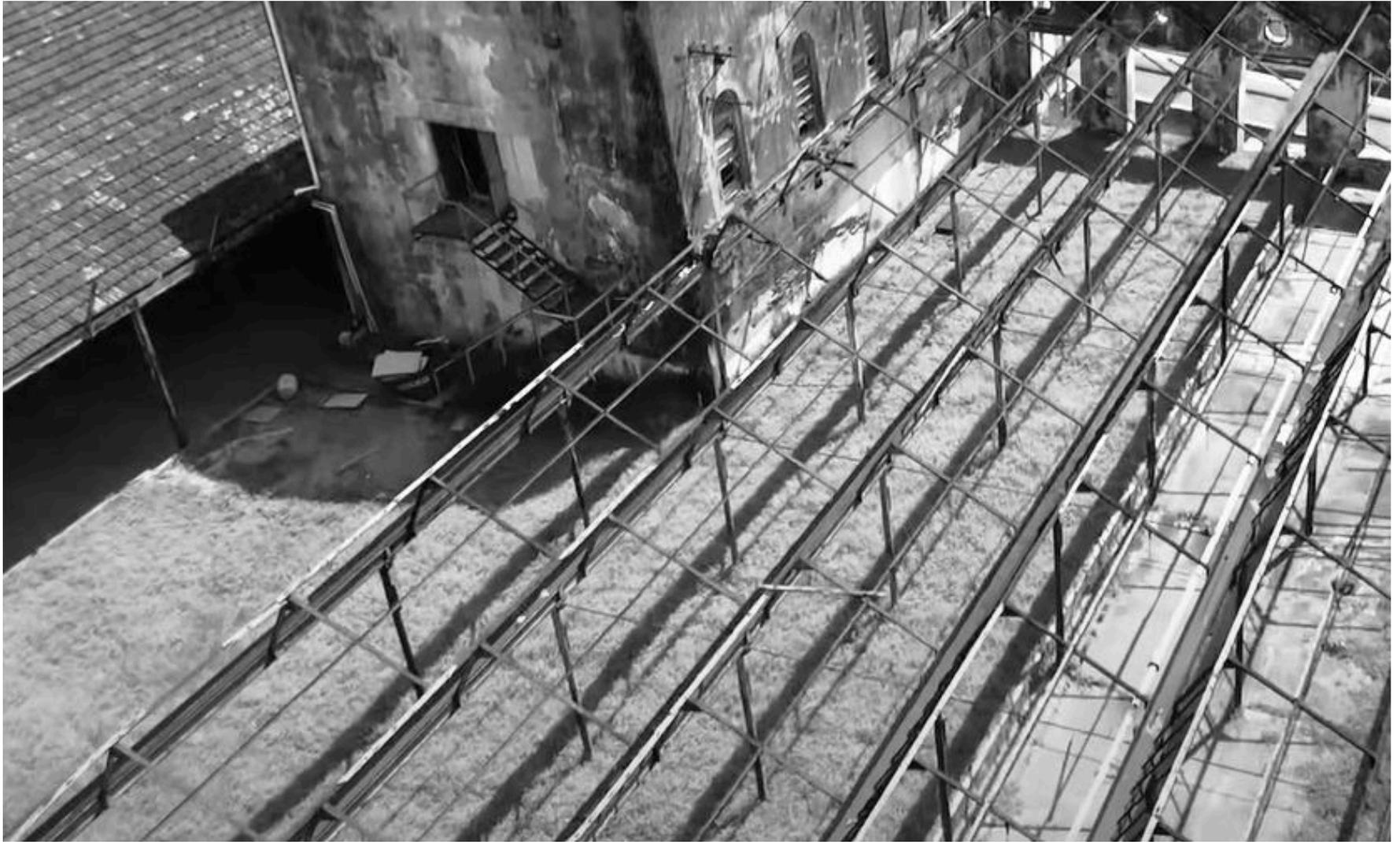
(F83) Vista aérea do Cotonifício - Galpão de Fiação. Cobertura vegetal no contrapiso, degradação de componentes estruturais; vegetação, crosta negra e perda de reboco nas paredes . Fonte: Autor, 2025.
