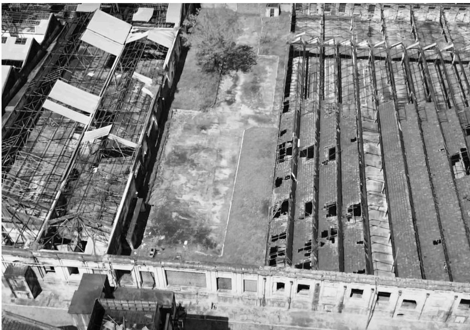
(F80) Vista aérea do Cotonifício - Galpão de Fiação (á direita) e Intervenções realizadas pelo BANORTE (á esquerda). Verifica-se o destelhamento da cobertura, com exposição e degradação de sua estrutura, o madeiramento original está ausente e as telhas cerâmicas encontram-se, em grande parte, danificadas. Há significativa ocupação do contrapiso por vegetação rasteira, desaparecimento das esquadrias, demolição de setores de seu perímetro e, crosta negra e infiltrações no reboco.
