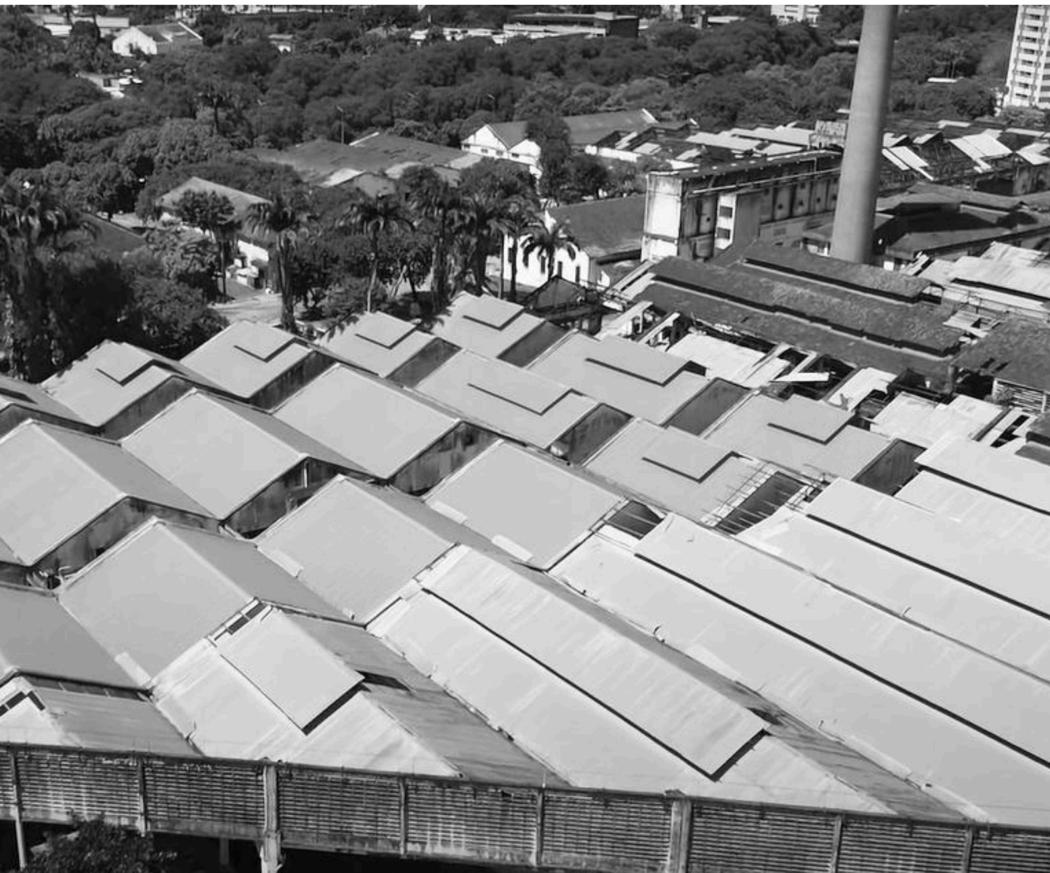
(F87) Vista aérea do Cotonifício - Galpões de acabamento e tinturaria. Registra-se a presença distintos materiais de revestimento na cobertura, divergindo da telha cerâmica francesa original do conjunto. A interferência do BANORTE levantou platibandas na fachada, essas construídas com cobogós em concreto. Fonte: Autor, 2025.
