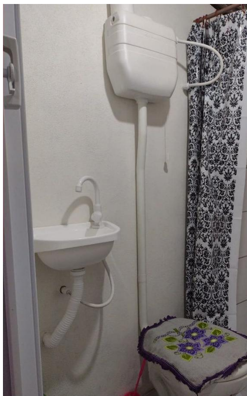
Figura 71 - Banheiro de Dona Nilma depois da reforma
