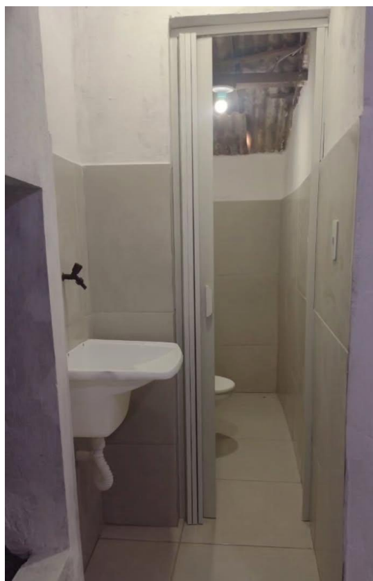
Figura 52 - Nova lavanderia de Virgilina depois da reforma
