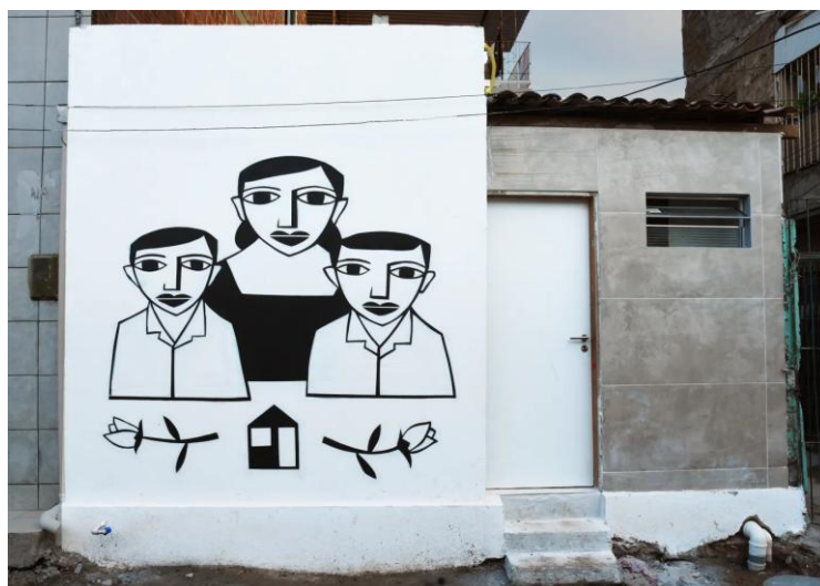
Figura 34 - Fachada da Casa de Dalva finalizada
