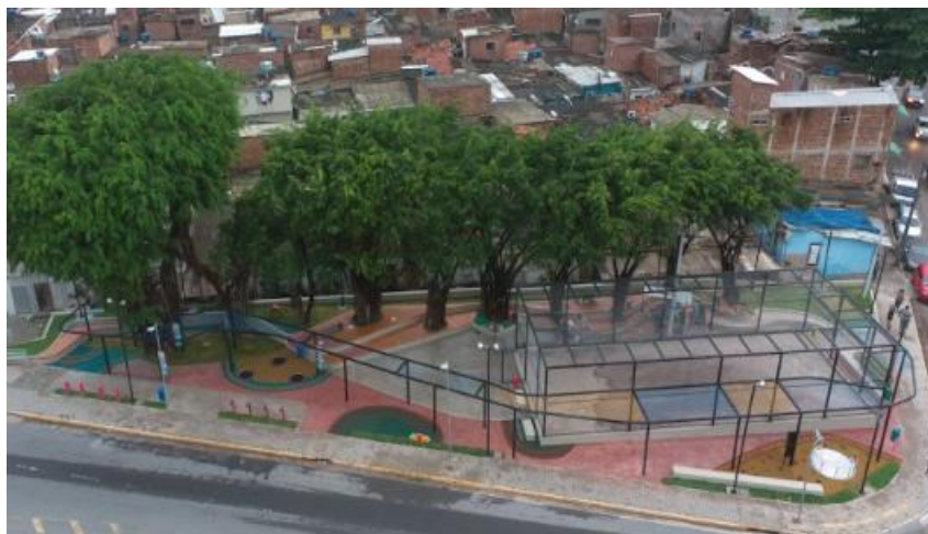
Figura 26 - Vista superior da Praça de Entra Apulso finalizada
