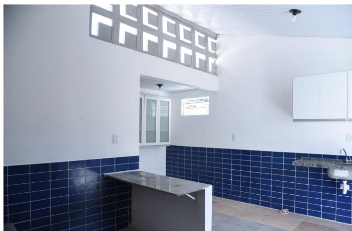
Figura 31 - Cozinha/Sala da Casa de Dalva finalizada
