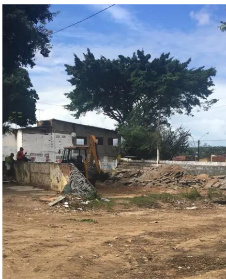
Figura 85 - Demolição da quadra do Manguirão
