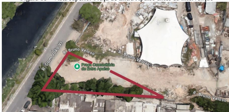
Figura 18 - Vista superior Praça de Entra Apulso antes da intervenção
