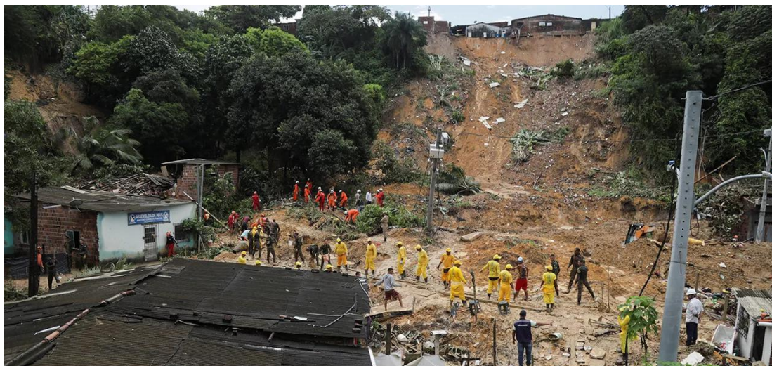
Figura 4 - Área de deslizamento causado por fortes chuvas no Recife em 2022
