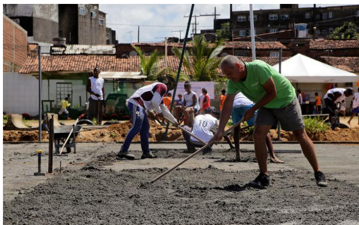
Figura 58 - Voluntários trabalhando em mutirão para a execução do Campo de futebol em Rio Doce
