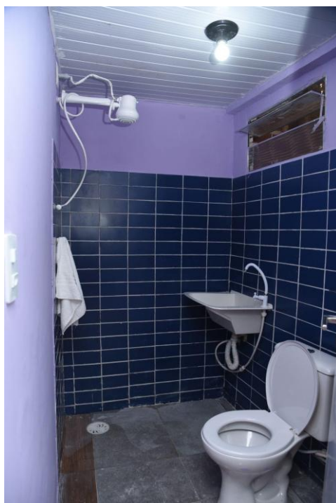
Figura 33 - Banheiro da Casa de Dalva finalizada
