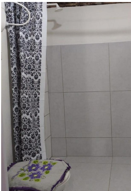
Figura 72 - Banheiro de Dona Nilma depois da reforma
