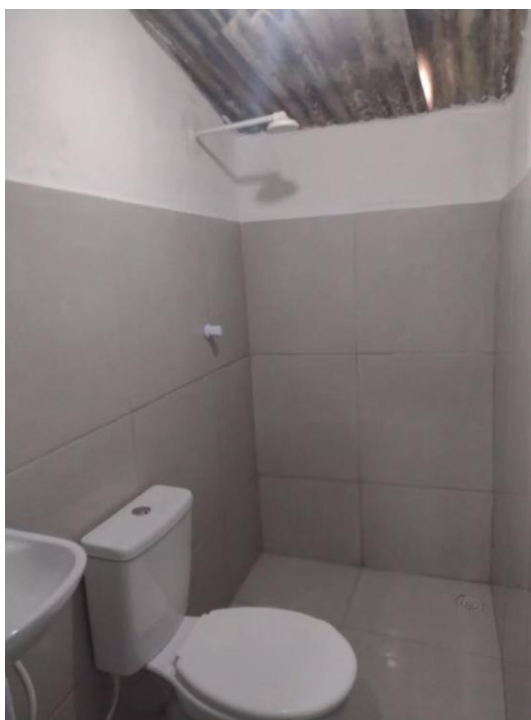
Figura 51 - Banheiro de Virgilina depois da reforma
