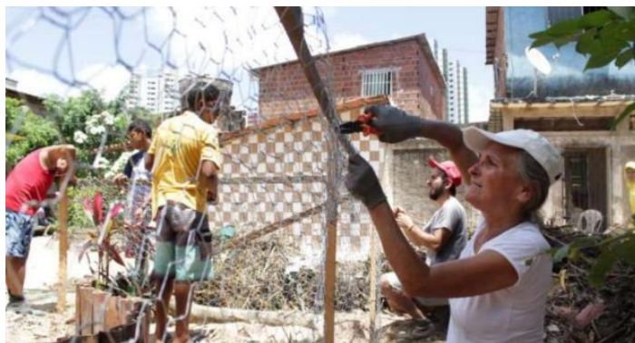
Figura 44 - Mutirão para construção de cercas da Horta Comunitária em Santa Luzia
