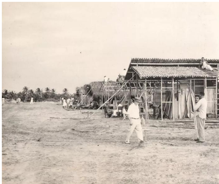
Figura 12 - Execução do projeto de Cajueiro Seco
