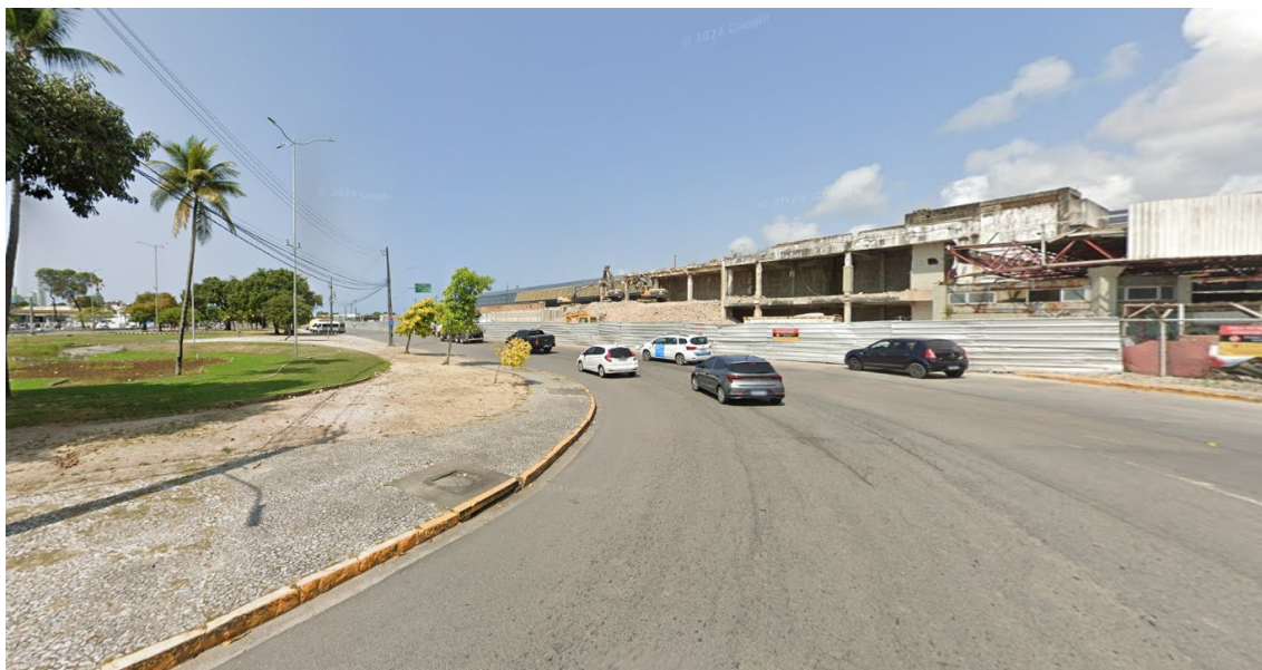
Figura 50 - Demolição do antigo terminal de passageiros do aeroporto do Recife
