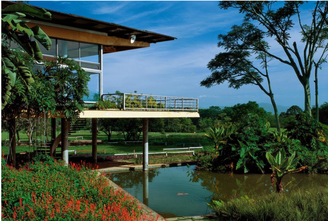
Figura 14 – Perspectiva externa da residência Olivo Gomes
