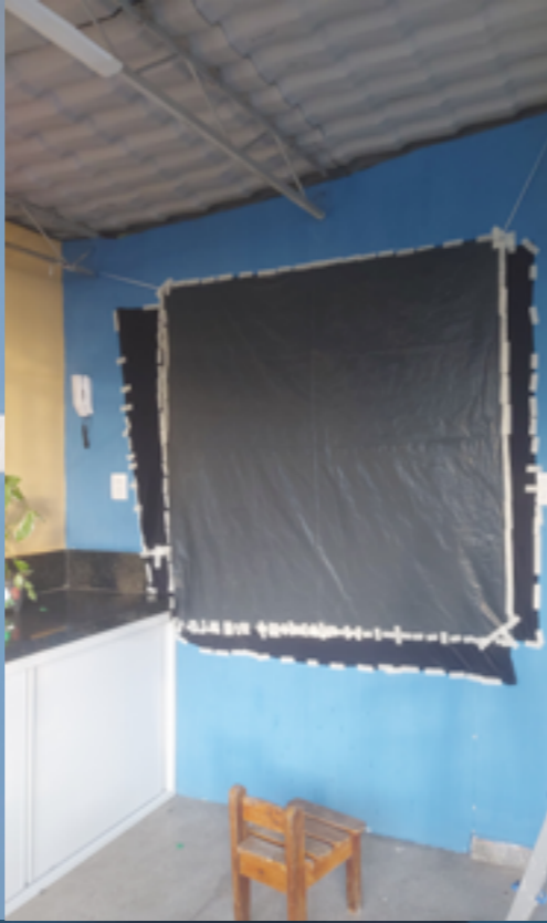
Figura 56 - Esquerda inferior. Lona pos-ta na parede oeste, visão interna, à noite.
