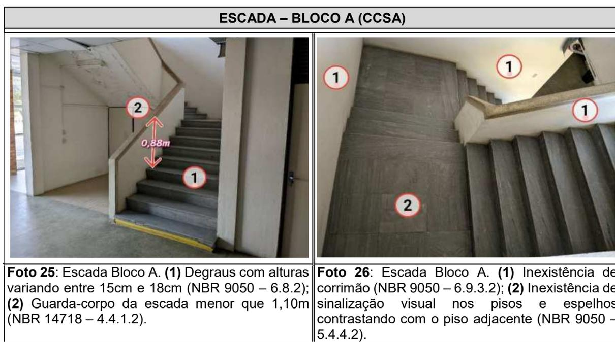
**Recomendações:** Realizar uma intervenção na escada para que os seus degraus tenham altura constante. Aumentar o guarda-corpo da escada para, no mínimo, 1,10m. Instalar corrimão duplo e contínuo, com alturas de 0,70m e 0,90m na face superior. Instalar sinalização visual nos espelhos e pisos, contrastando com o piso adjacente.
