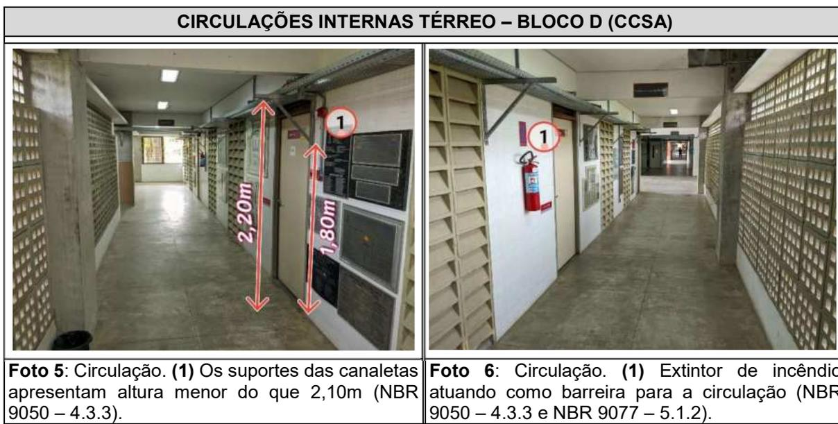
**Recomendações:** Substituição do suporte das canaletas. Instalar os extintores de incêndio fora da rota de fuga.
