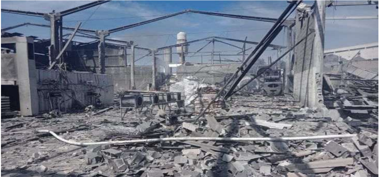
Figura 14 - Amplitude da explosão da uma caldeira, ocorrida em 2023, vista ao nível do solo
