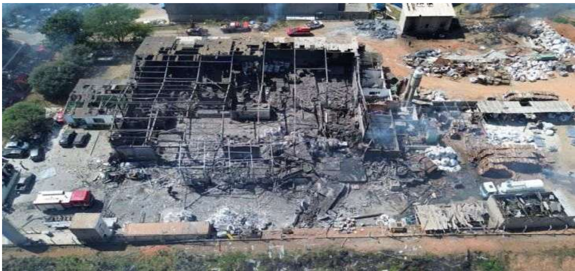
Figura 13 - Amplitude da explosão da uma caldeira, ocorrida em 2023, vista aérea
