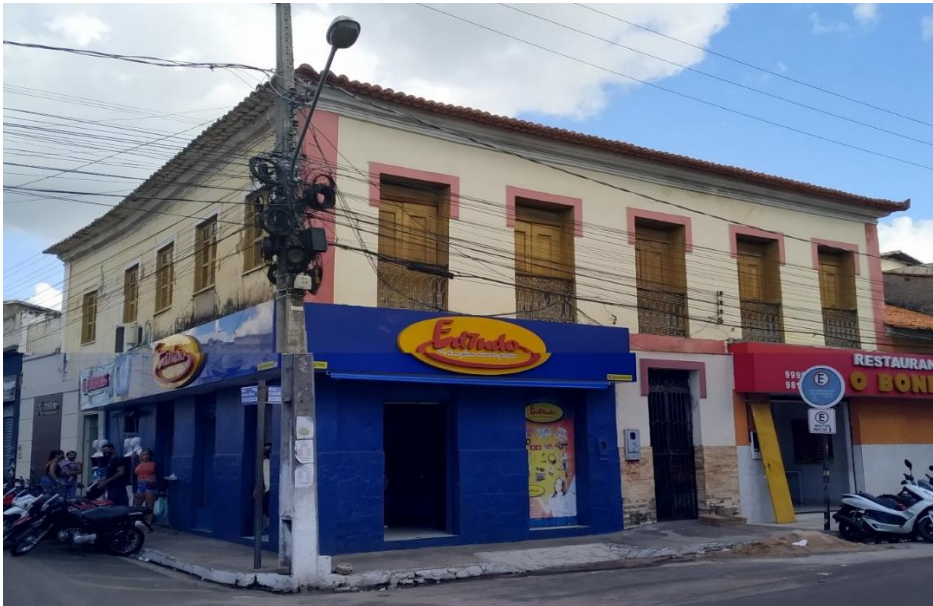
Figura 17 - Casarão no largo da Praça da Matriz, estado atual
