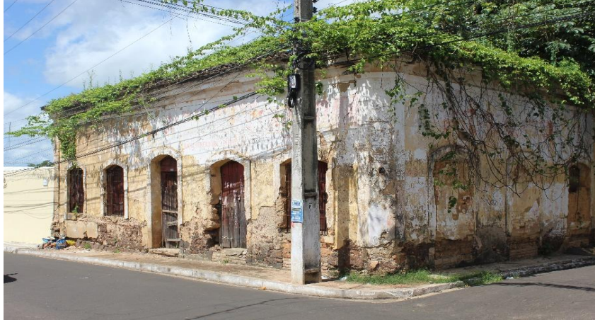
Figura 15 - Casarão na rua Riachuelo, estado atual
