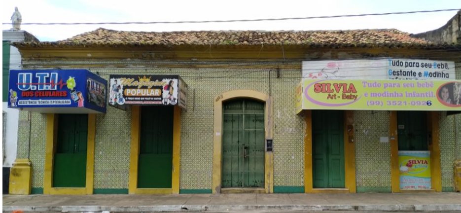
Figura 16 - Casarão de Dona Ivelta (praça da matriz), estado atual
