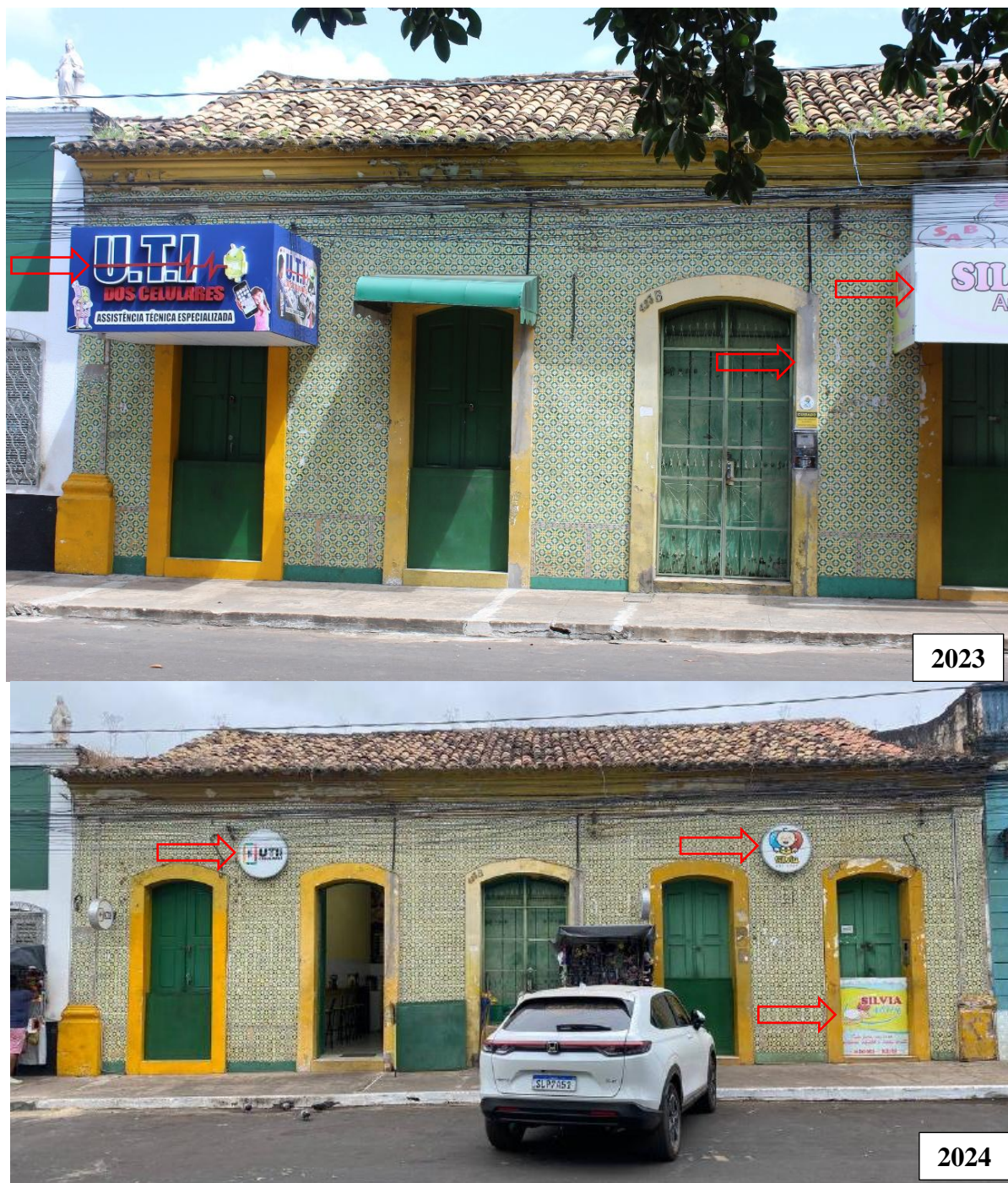
Figura 34 - Fachada do casarão de Dona Ivelta
