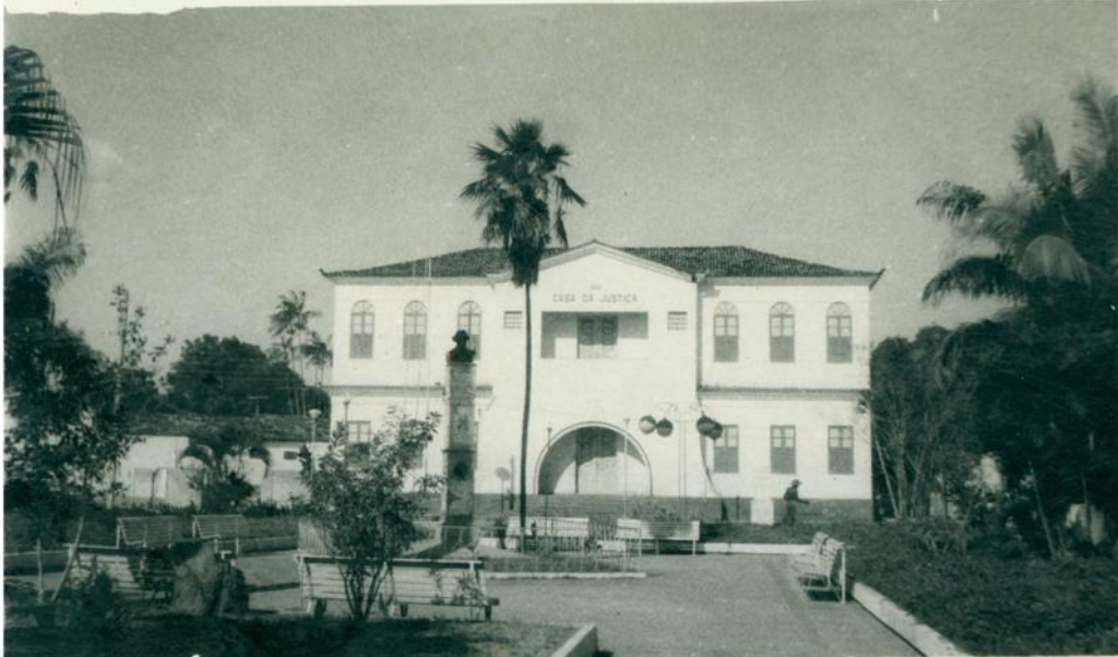
Figura 12 - Fachada da antiga Casa da Justiça no século XX
