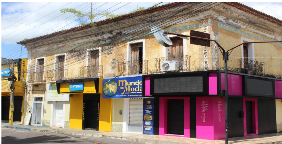
Figura 9 - Edifício Duque de Caxias, estado atual
