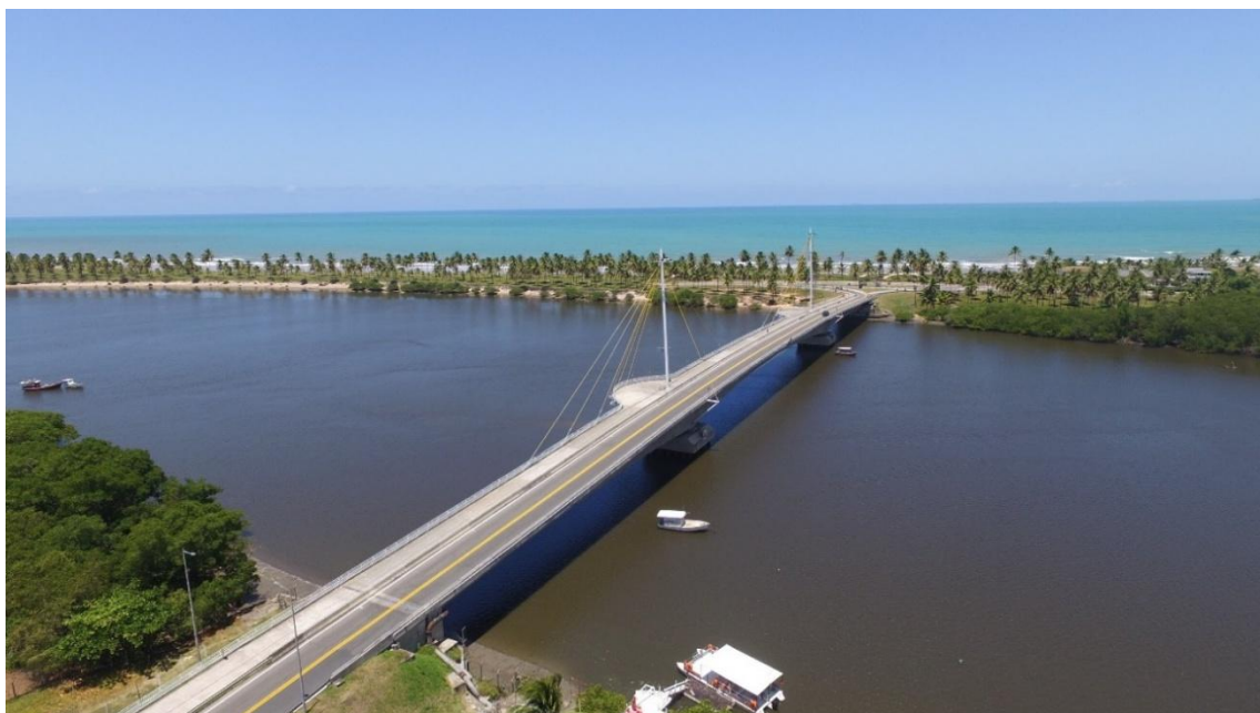
Figura 1 – Ponte sobre o Rio Jaboatão, construída pela Concessionária Rota dos Coqueiros
