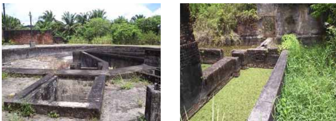
Figura 12 Tanques de decantação para tratamento de efluentes da antiga Fábrica de Tecidos Rio Tinto.
