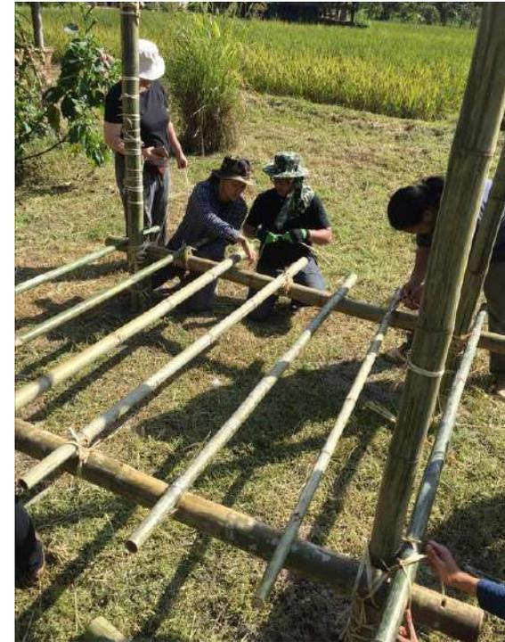
FIG 30: ESTRUTURA DE SUPORTE DO PISO CONECTADAS POR AMARRAÇÕES EM CORDA.
