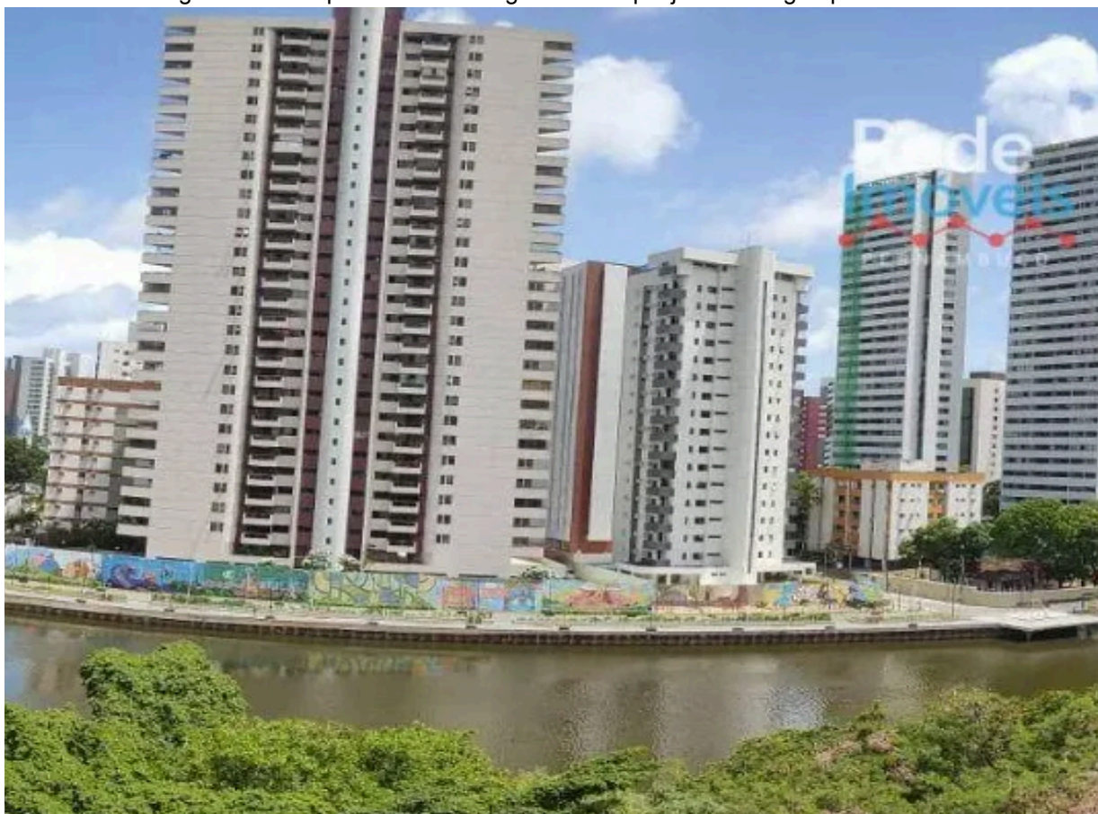
Figura 51 - Parque linear na margem do rio que já foi entregue pelo PPC
