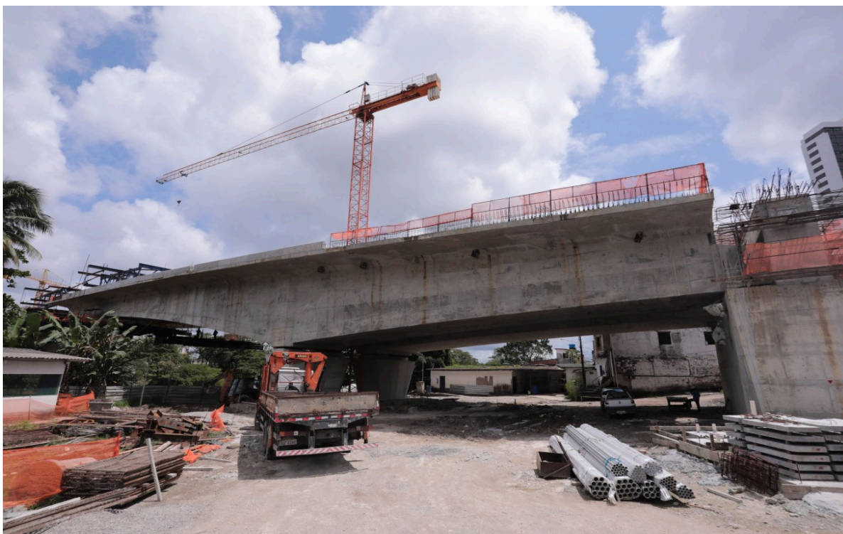
Figura 50 - Ponte que liga Monteiro à Iputinga em construção
