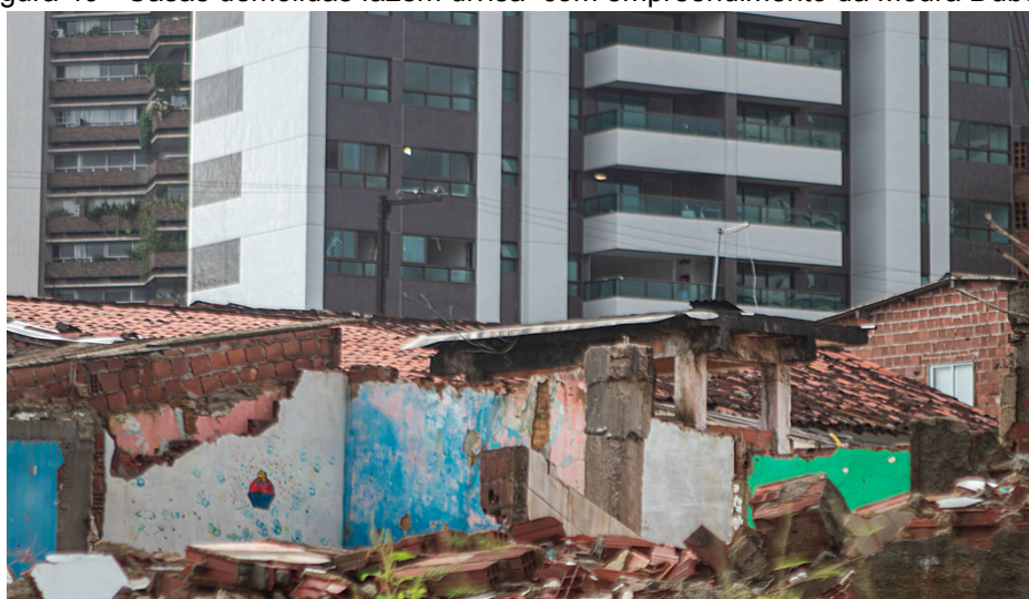
Figura 49 - Casas demolidas fazem divisa com empreendimento da Moura Dubeux
