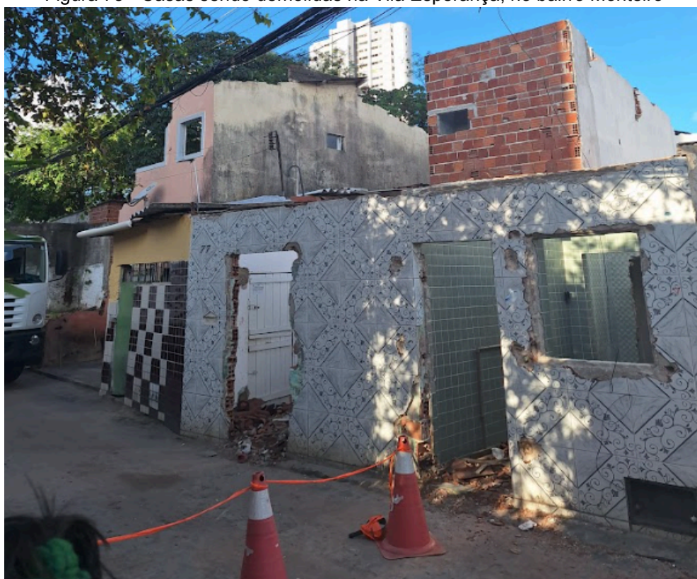
Figura 75 - Casas sendo demolidas na Vila Esperança, no bairro Monteiro
