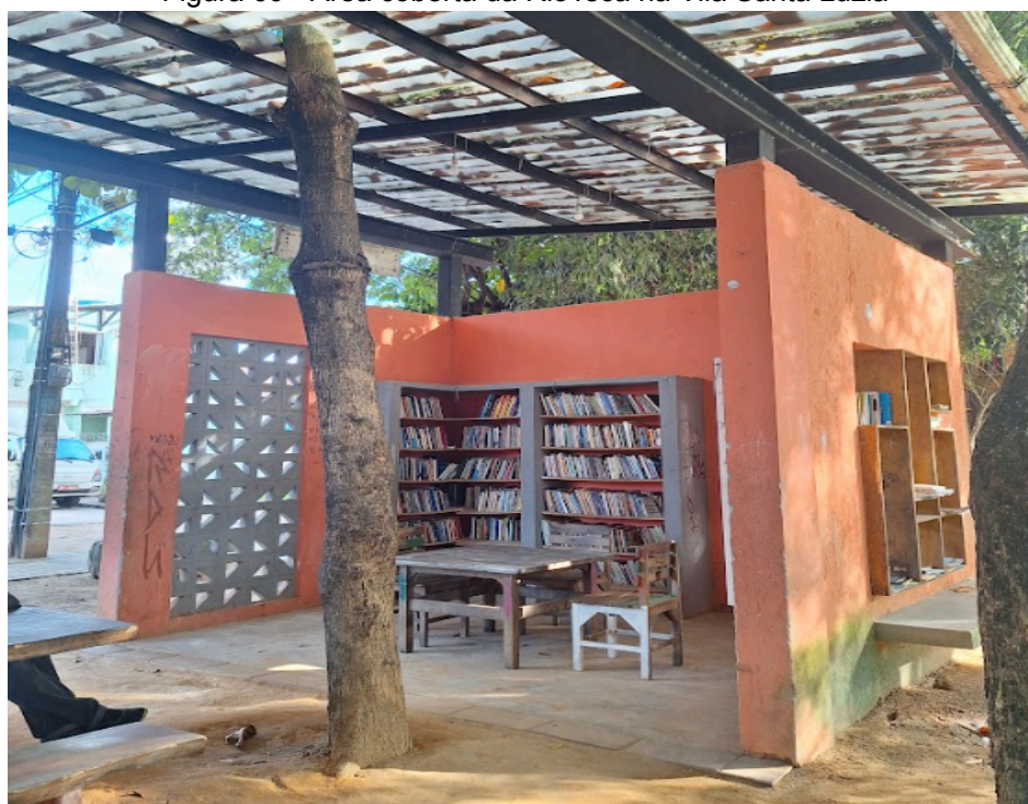
Figura 69 - Área coberta da RioTeca na Vila Santa Luzia
