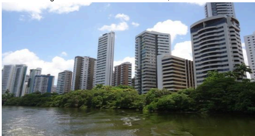
Figura 48 - Edifícios na Av. Beira Rio, na Madalena
