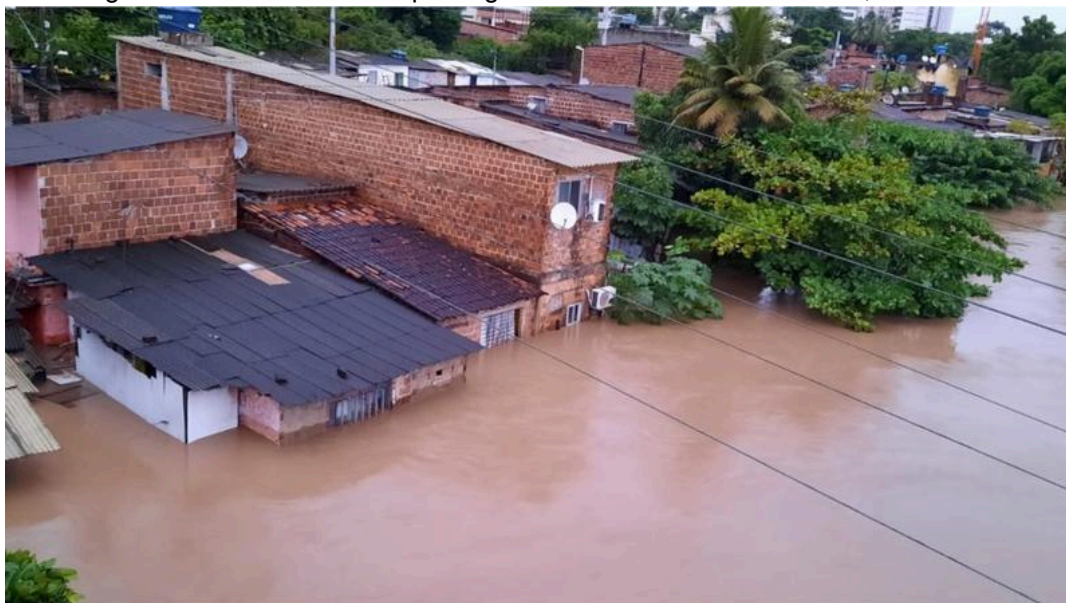
Figura 37 - Casas tomadas pela água em 2022 no bairro Monteiro, em Recife
