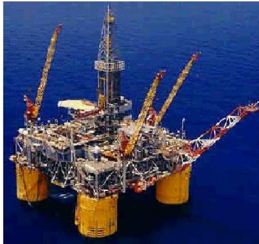
Figura 2.05 – Plataformas *Tension Leg*
