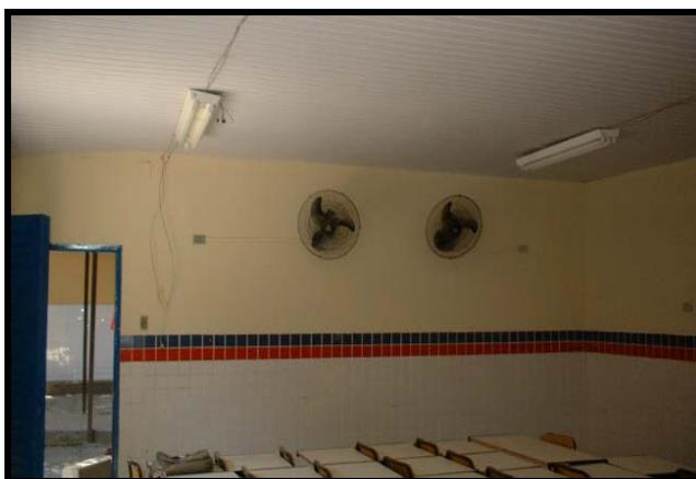
Figura 4.45 - Instalação elétrica exposta.
