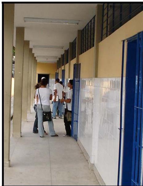
Figura 4.33 - Estreitamento da circulação em função da estrutura do pilar lançado na circulação.
