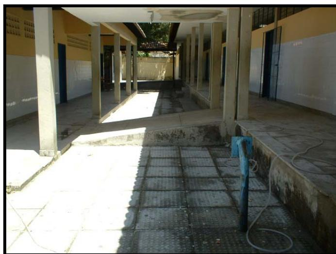
Figura 4.35 – Rampa com inclinação acima da recomendada.
