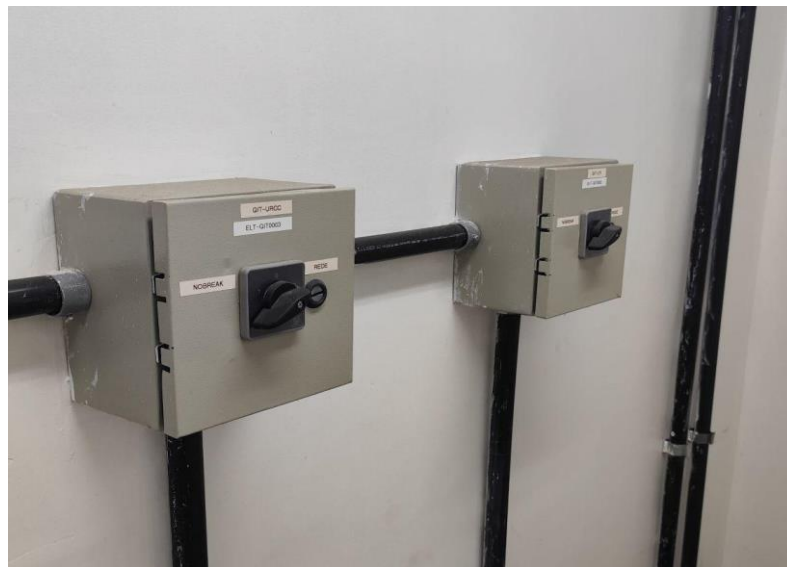
Figura 19 – Chave seletora de alimentação dos sistemas IT-médico.
