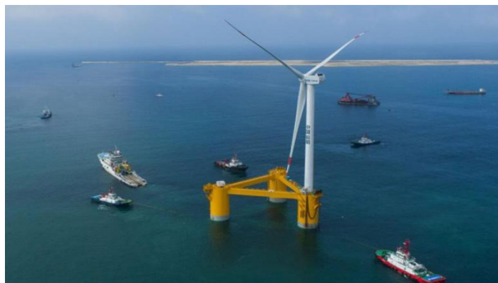
Figura 10: Plataforma semissubmersível de uma turbina eólica offshore.
