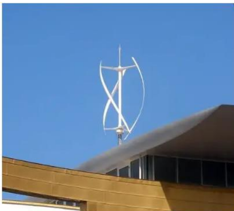
Figura 3: Exemplo de Turbina Eólica de Eixo Vertical.
