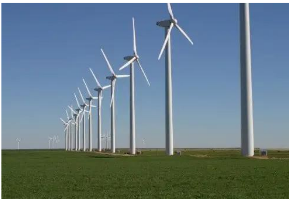
Figura 2: Exemplo de Turbina Eólica de Eixo Horizontal.
