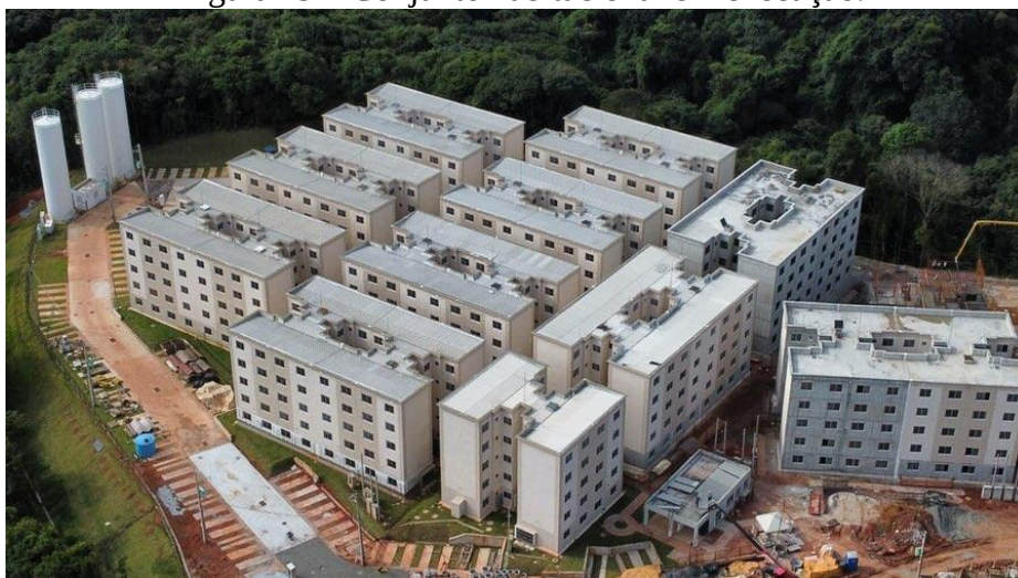
Figura 19 – Conjunto habitacional em execução.
