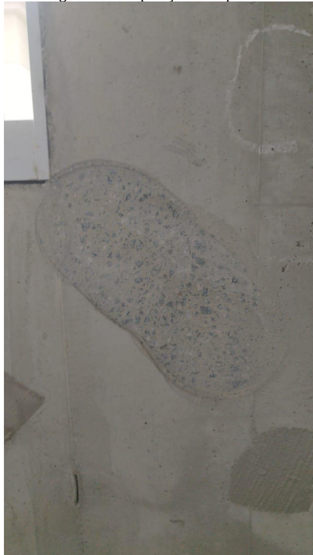
Figura 34 - Preparação da superfície
