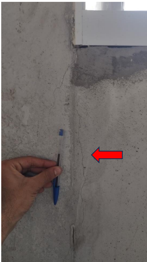
Figura 26- Fissura Térreo
