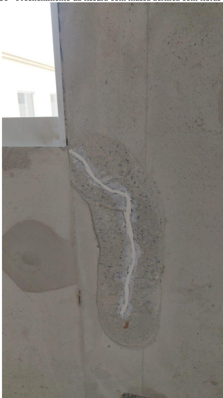
Figura 36 - Preenchimento da fissura com massa acrílica com fibras minerais
