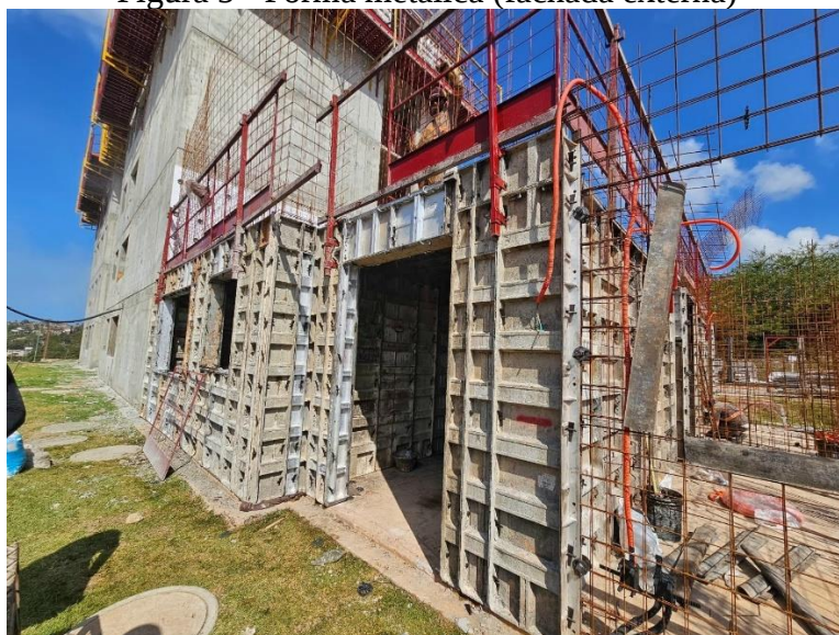
Figura 5 - Forma metálica (fachada externa)
