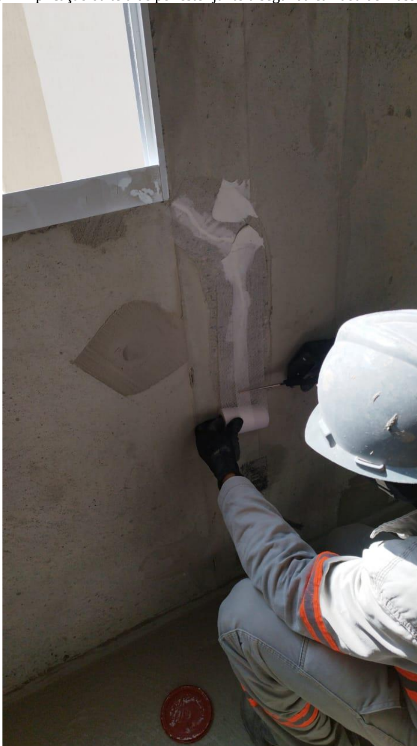
Figura 37 - Aplicação da tela de poliéster junto a segunda camada de massa acrílica
