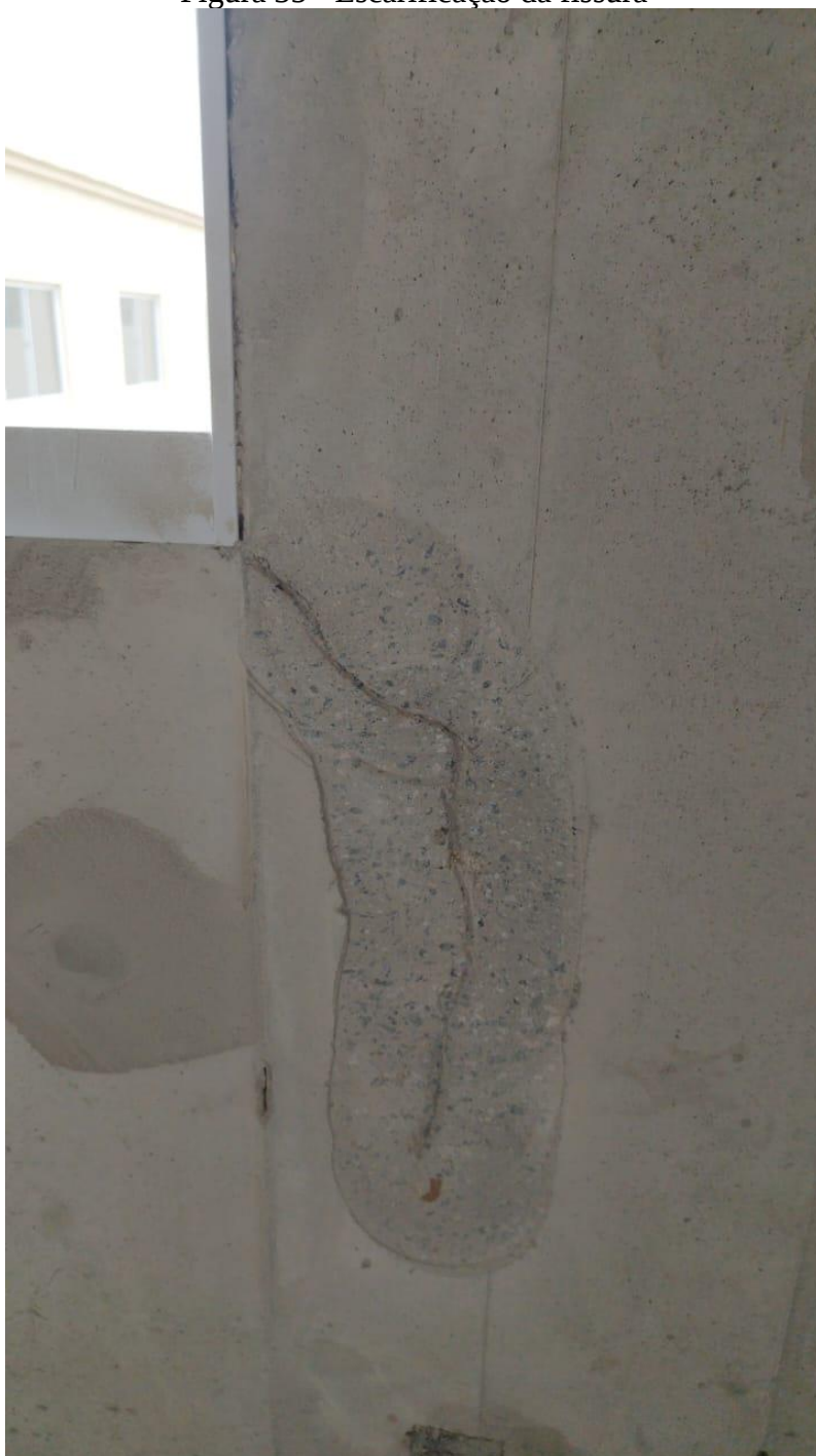
Figura 35 - Escarificação da fissura
