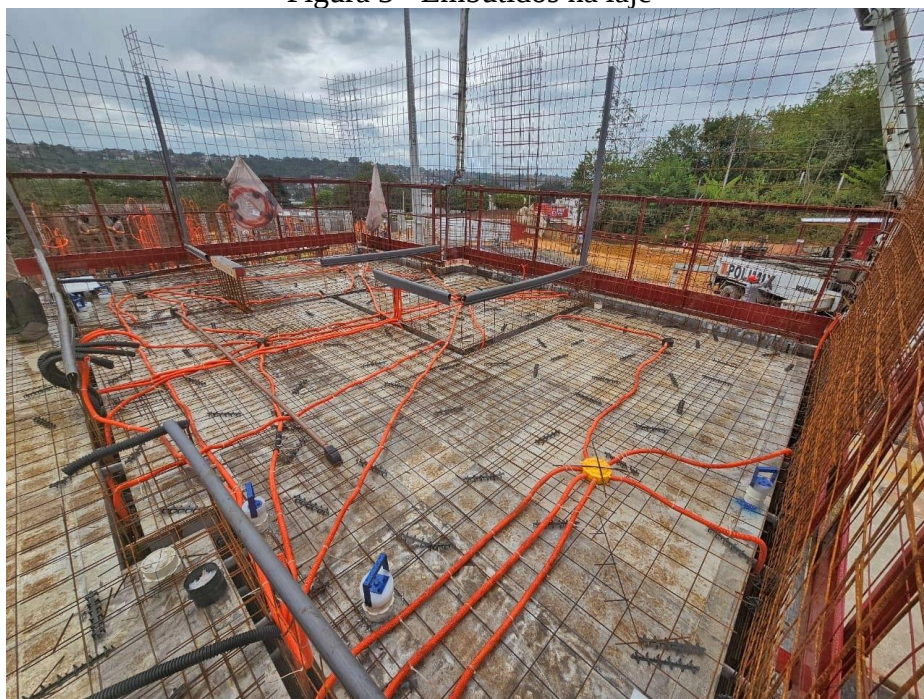
Figura 3 - Embutidos na laje
