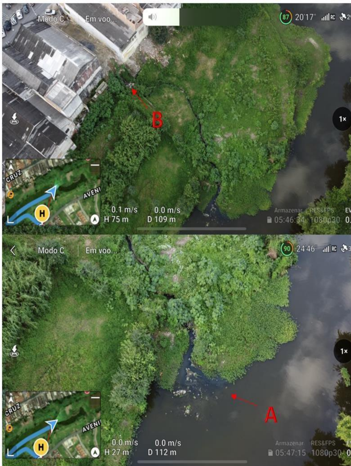
Figura 16 – Fonte pontual de poluição no Rio Capibaribe, ao lado das futuras instalações do Centro de Artesanato de Limoeiro, no centro comercial, Pernambuco
