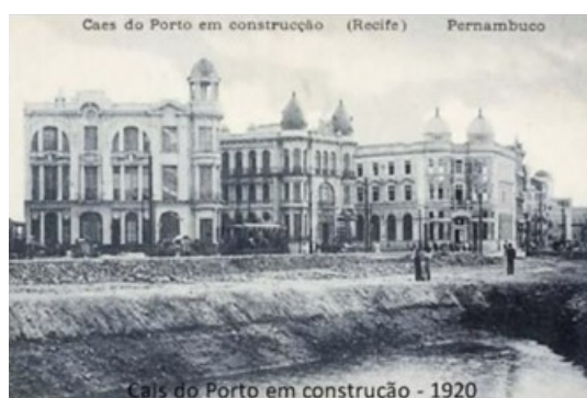
Figura 7 – Construção do cais do porto no Bairro do Recife 7
