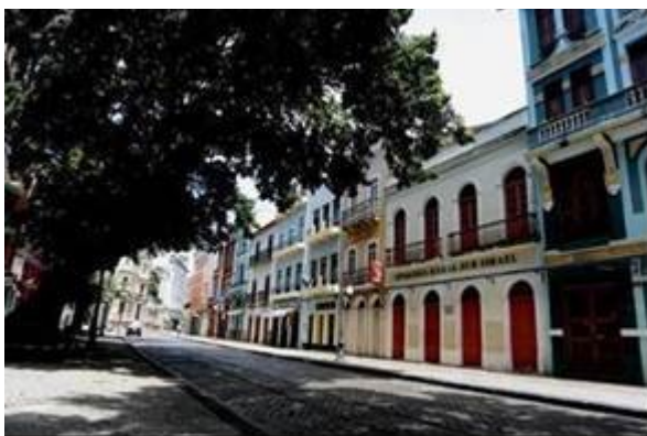
Figura 9 – Vista parcial da Rua do Bom Jesus 11
