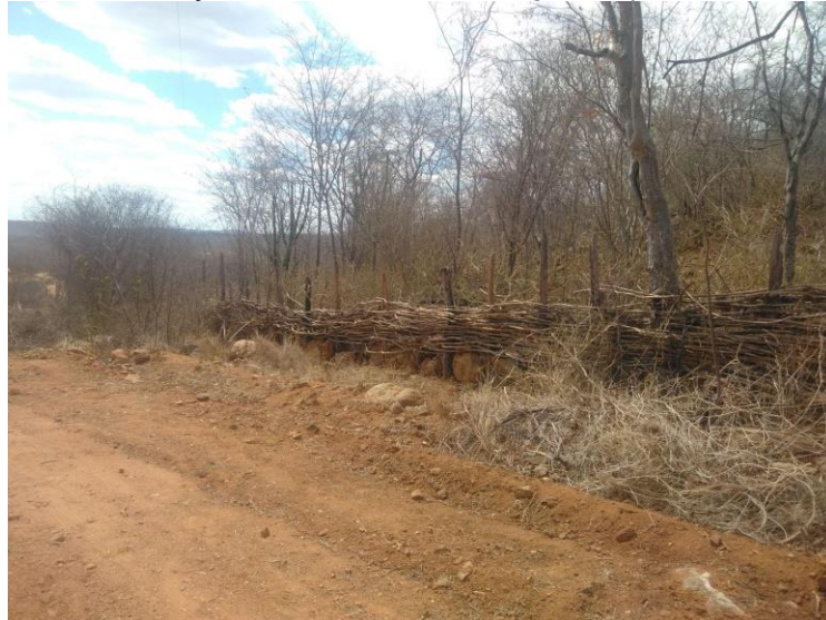
Ilustração 9 - zona rural de Sertânia, a cerca de vara trançada é a estrutura principal usada na contenção de animais de médio/grande porte
