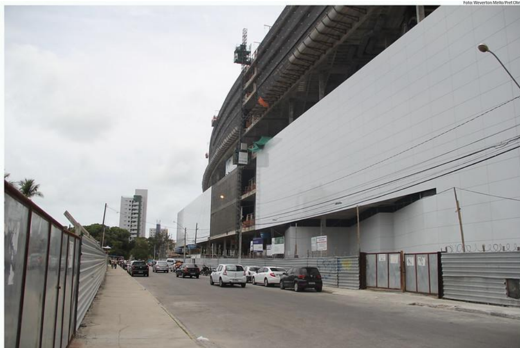
Imagem 10. Obras da construção do Patteo Olinda Shopping (onde hoje é a entrada principal, paralela à praia) em 2016.
