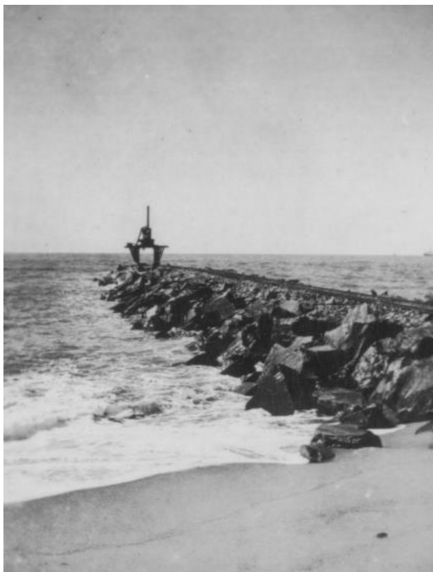
Imagem 6: Construção de diques de proteção contra o avanço do mar em Olinda, 1960
