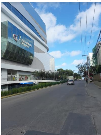
Imagem 12. Via pública e entrada lateral (Sul) do shopping em 2022.
