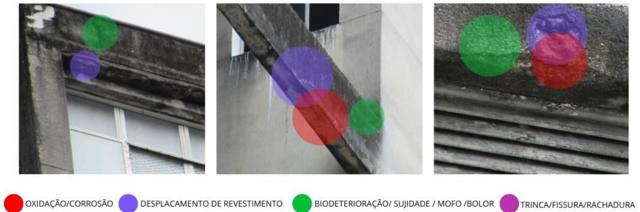
Quadro 8- Fachada 3 do edifício Canadá.
