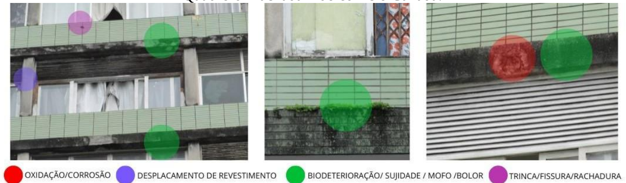
Quadro 6- Fachada 1 do edifício Canadá.
