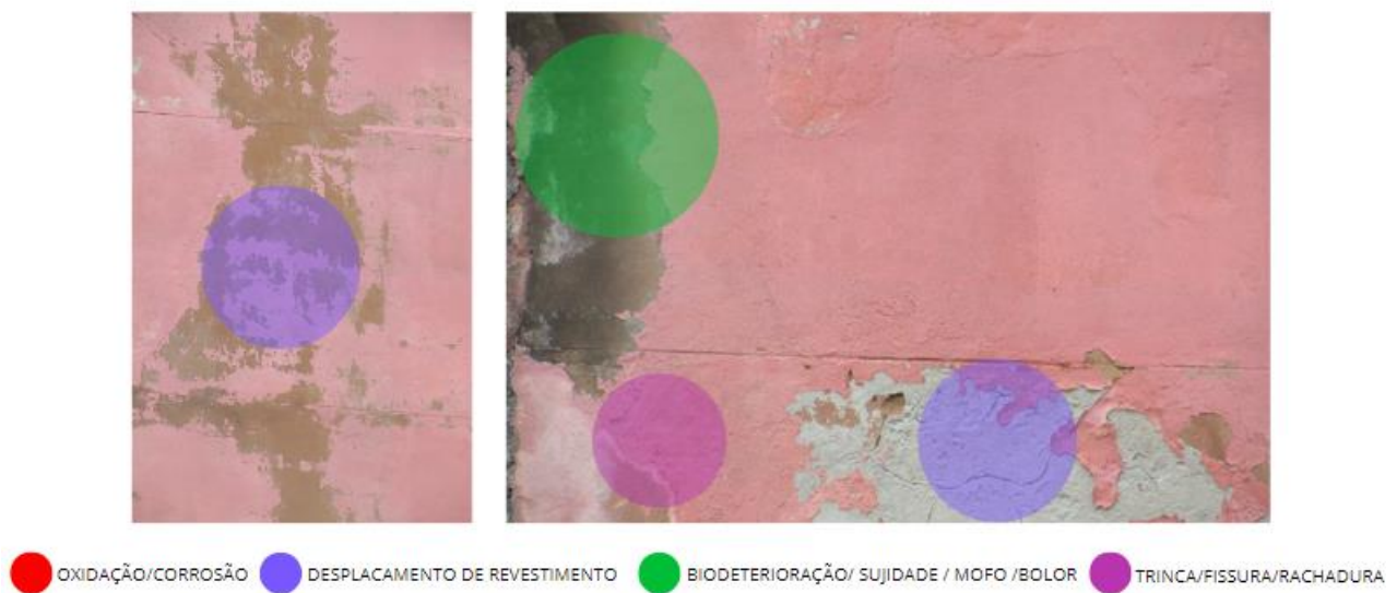
Quadro 12- Fachada 3 do edifício California.
