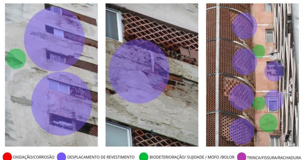
Quadro 5 - Fachada 4 do edifício Pirapama.
