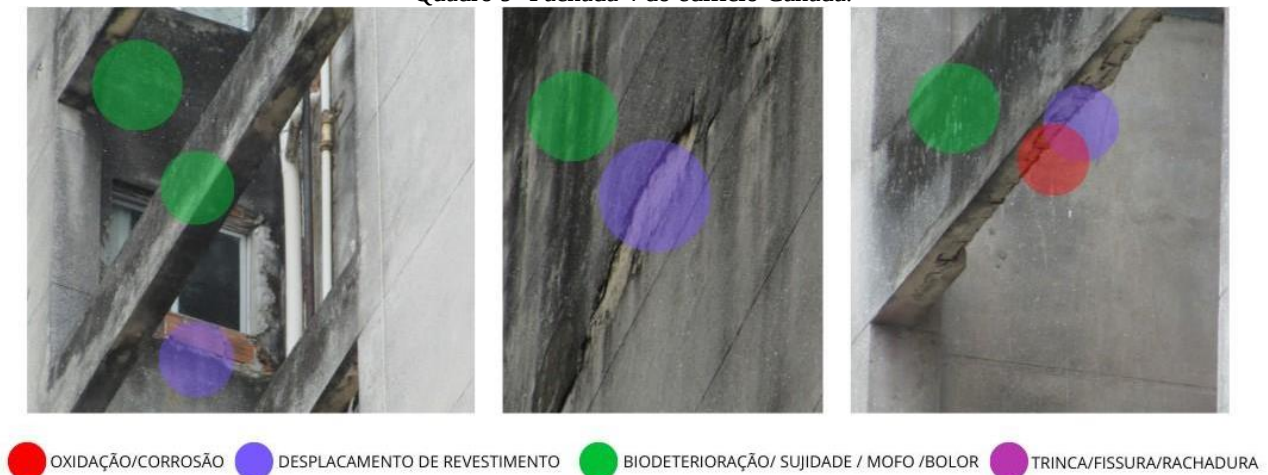
Quadro 9- Fachada 4 do edifício Canadá.
