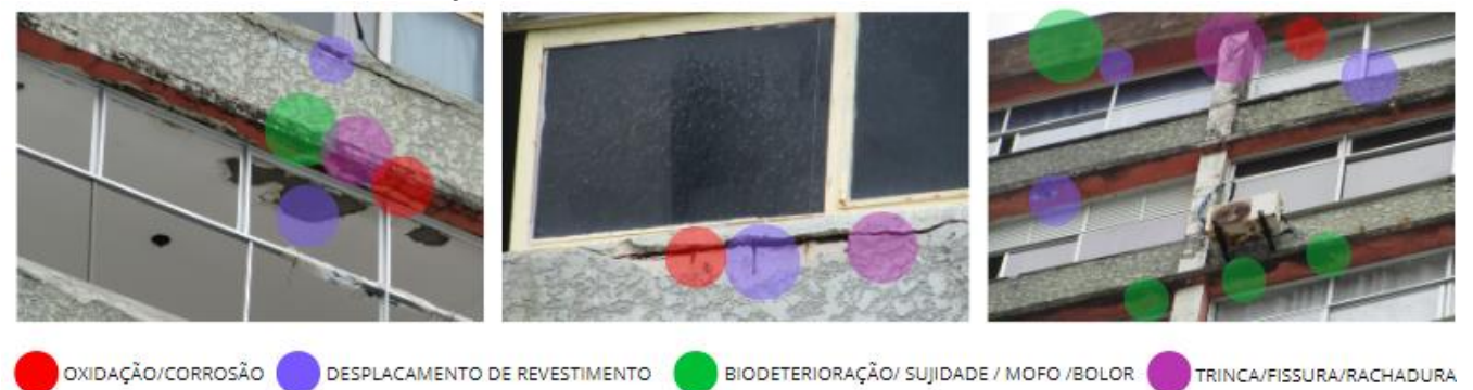
Quadro 13- Fachada 4 do edifício California.
