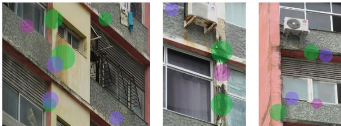
Quadro 11- Fachada 2 do edifício California.
