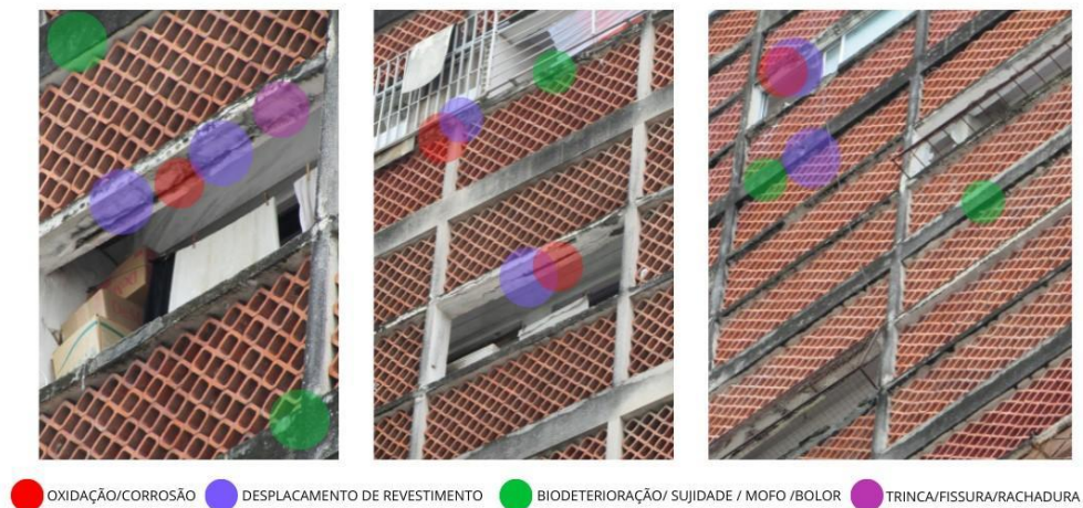
Quadro 3- Fachada 2 do edifício Pirapama.
