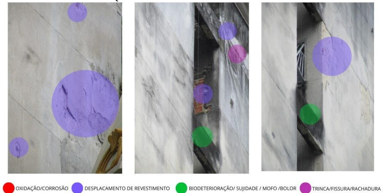
Quadro 7- Fachada 2 do edifício Canadá.
