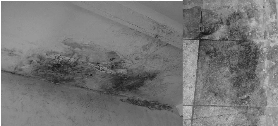
Figura 4: mofo(esquerda) e bolor (direita).
