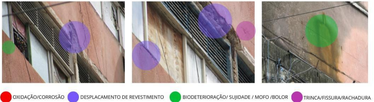
Quadro 4- Fachada 3 do edifício Pirapama.
