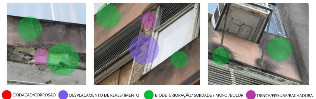
Quadro 2- Fachada 1 do edifício Pirapama.
