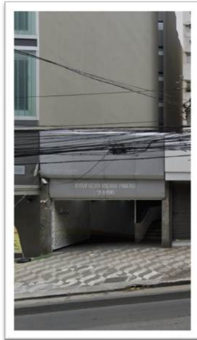
Figura 7 — Fachada do prédio
