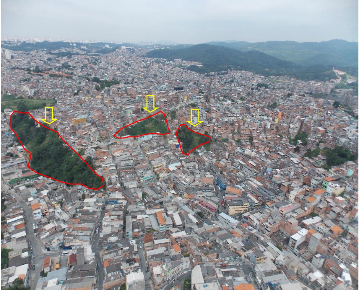
Figura 16 - Fotografia aérea oblíqua obtida em sobrevoo de helicóptero, cujas setas indicam as moradias em situação de perigo a escorregamento de terra – Jardim Hebron - Jaçanã - Zona Norte da cidade de São Paulo (SP)
