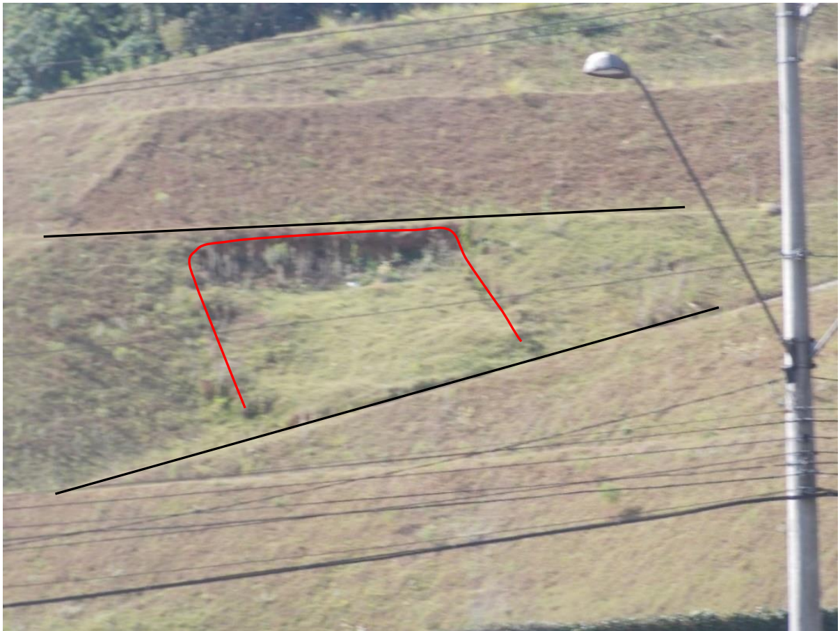
Figura 3 - Escorregamento rotacional (linhas vermelhas) em cortes artificiais (retaludamento) em terreno para construção de vias de acesso (linhas escuras) a uma empresa na cidade de Santo André – SP
