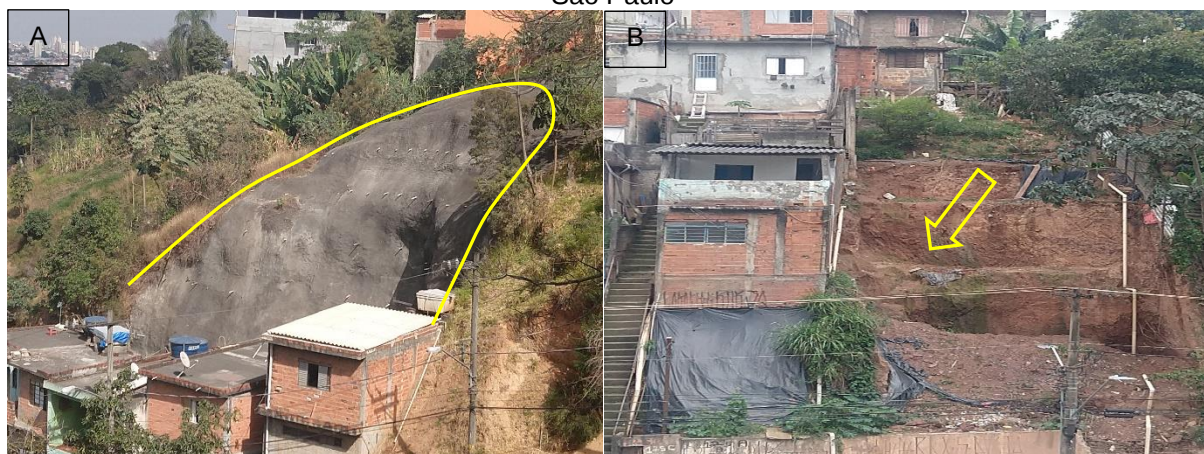
Figura 33 - As imagens correspondem a exemplos de cortes em relevos para construção de residências. Na figura A, obra de contenção em cicatriz de escorregamento ocorrido em corte de relevo para construção de moradias no Jardim Corisco, Zona Norte de São Paulo. Na figura B, a seta indica corte em relevo para construção de moradia na região do Jardim Damasceno, Zona Norte de São Paulo
