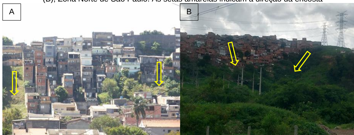
Figura 36 - Moradias autoconstruídas em local com declividade acentuada e em situação de perigo a escorregamentos muito alto localizadas no bairro Jardim Elba, Zona Leste (A) e Jardim Vista Alegre (B), Zona Norte de São Paulo. As setas amarelas indicam a direção da encosta
