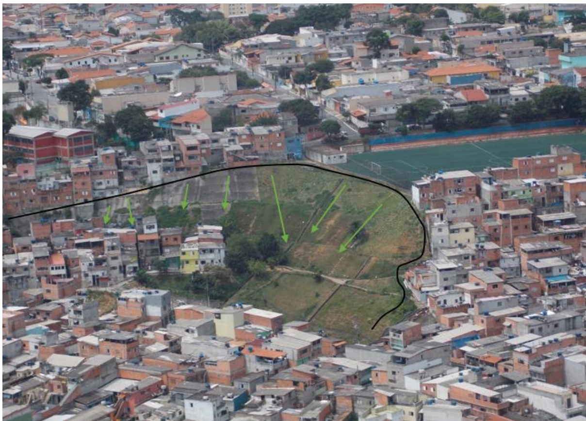
Figura 29 - Exemplo de fotografia aérea obtida durante o sobrevoo de helicóptero realizado no dia 02/12/2021 – São Paulo (SP). Na imagem, as setas apontam casas em local de intensa vulnerabilidade e obra de contenção de encosta – Vila Dania Mungo Park – Zona Leste – São Paulo
