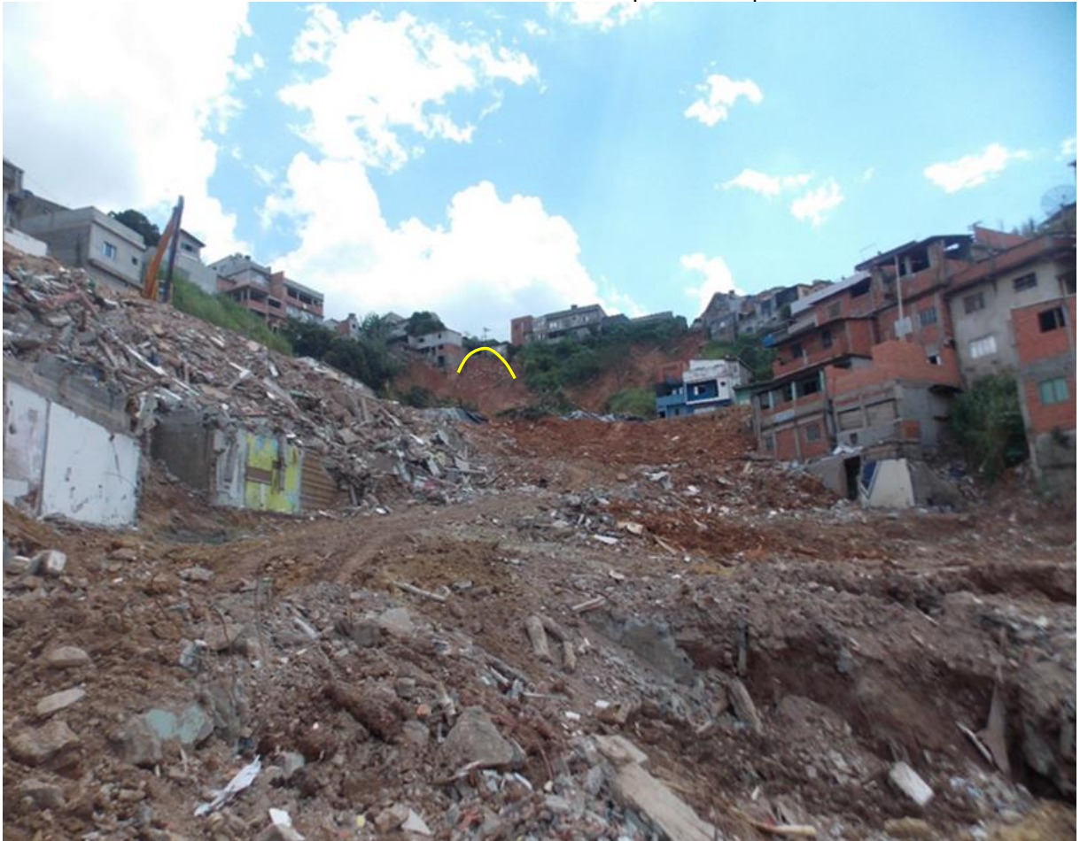
Figura 5 - Cicatriz de escorregamento de terra ocorrido no Bairro Parque Paulista - Franco da Rocha – RMSP. A linha amarela indica o ponto de ruptura
