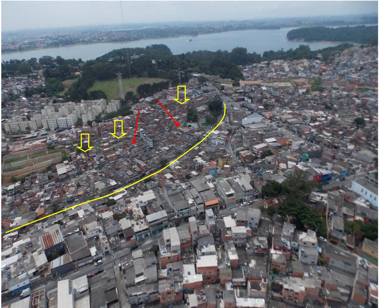
Figura 14 - Fotografia aérea oblíqua obtida em sobrevoo de helicóptero, cujas setas indicam as residências em situação de perigo a escorregamento de terra – Bairro do Grajaú - Zona Sul da cidade de São Paulo (SP)
