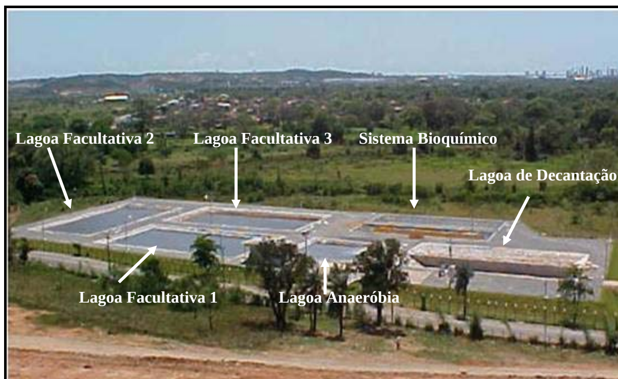
Figura 3.14 - Estação de Tratamento de Chorume - ETC
