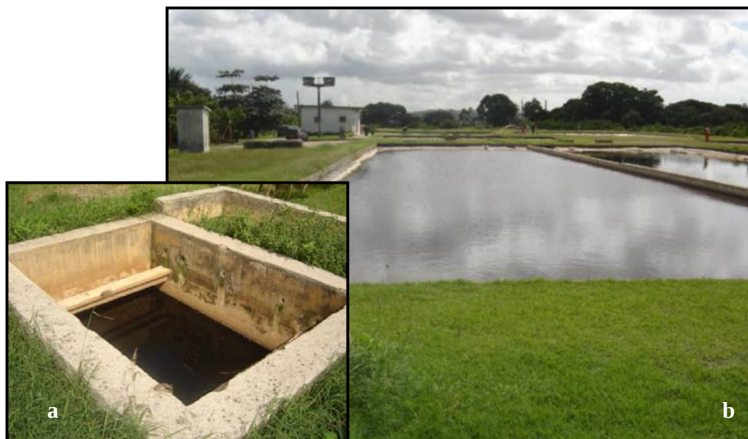
Figura 3.21 - Entrada do Sistema de Tratamento de Chorume (a); Lagoa de Decantação (b)
