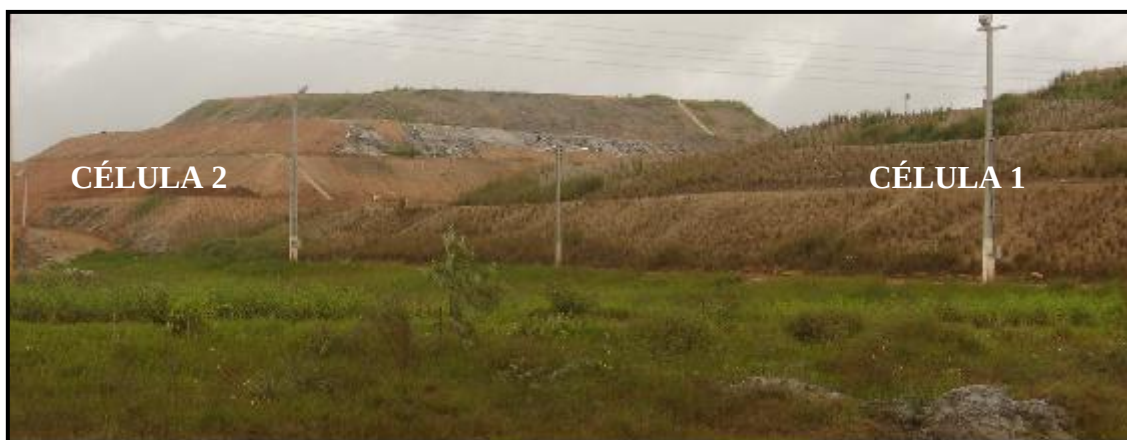
Figura 3.5 - Vista as Células 1 e 2 do Aterro Sanitário Metropolitano de João Pessoa.
