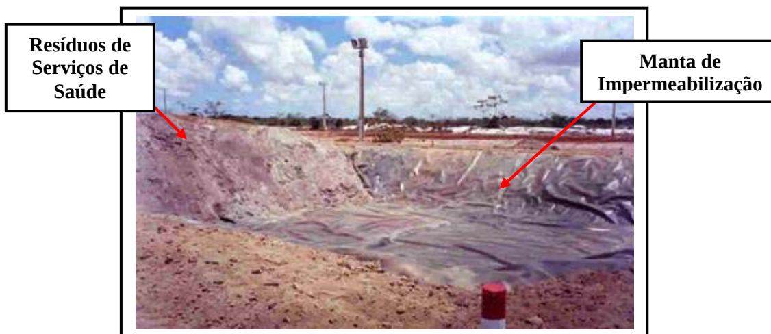
Figura 3.4 - Célula destinada aos resíduos de serviço de saúde.
