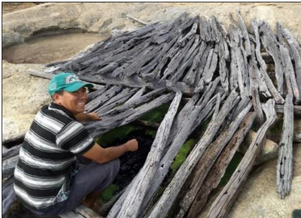
Figura 80 – Seu Paulo, da Comunidade Santo Antônio – Fartura do Piauí, mostrando a água da chuva armazenada no caldeirão coberto com madeira para diminuir a evaporação
