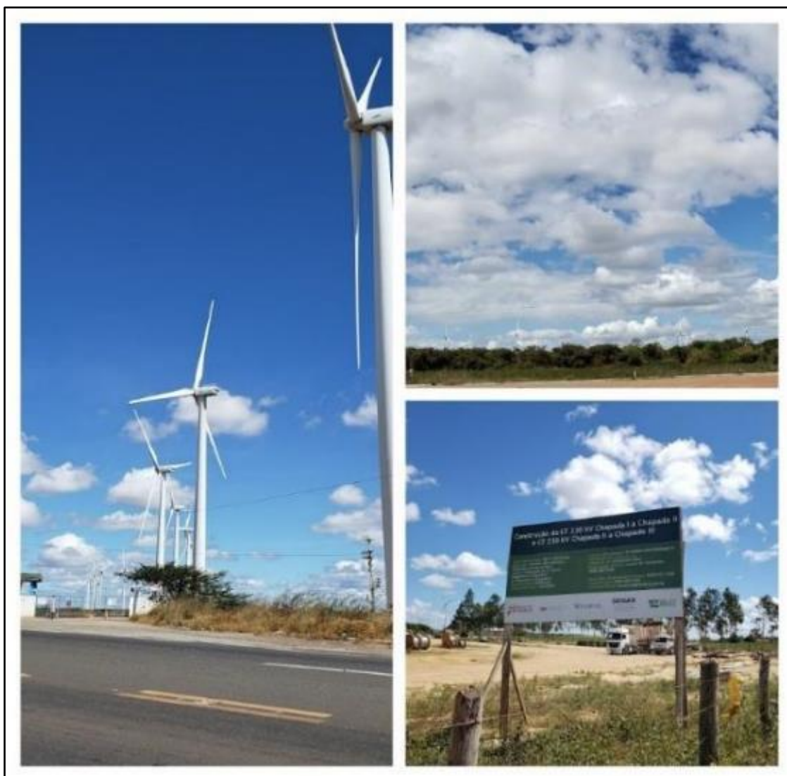
Figura 27 – Complexo Eólico Caldeirão Grande – Chapada do Araripe – Piauí
