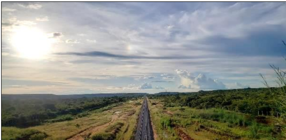
Figura 33 - Trecho concluído da Transnordestina, Município de Simplício Mendes – Piauí.
