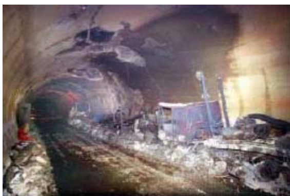
Figura 2.23 - Cavidades devido ao lascamento no Mont Blanc Tunnel – França/Itália (1999). Fonte: Costa et al (2002)
