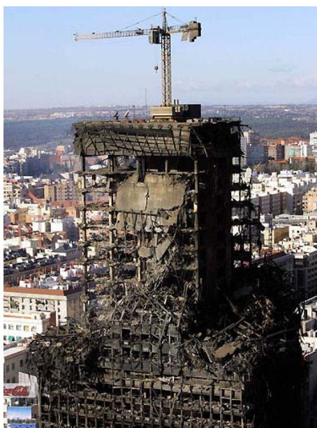
Figura 1.2 – Edf. Windsor após o incêndio Madrid, Espanha (2005)
