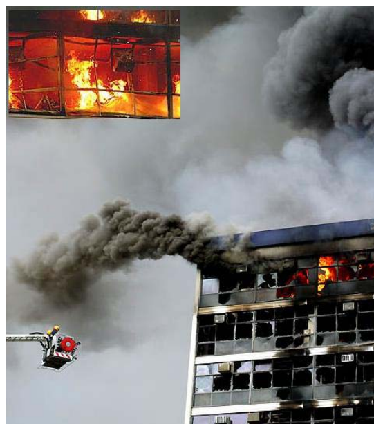
Figura 1.4 – Incêndio no prédio do INSS, acima detalhe do interior do prédio em chamas – Brasília, Brasil (2006).
