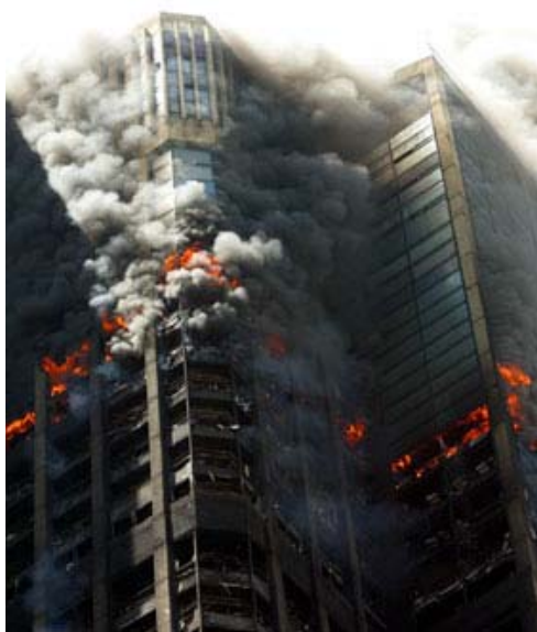
Figura 1.1 – Incêndio no Edf. Parque Central – Caracas, Venezuela (2004)
