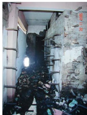
Figura 8 – Hall de acesso ao WC feminino
