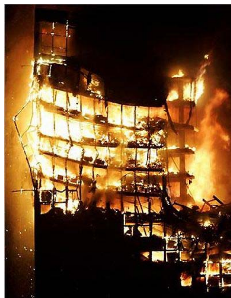
Figura 1.3 – Incêndio no Edf. Windsor Madrid, Espanha (2005)
