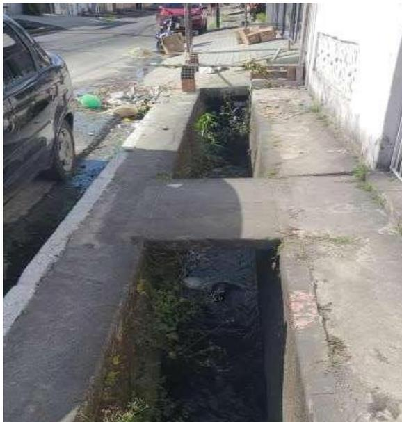
Figura 44 - Evidência de esgoto a céu aberto na CIS Cidade Operária
