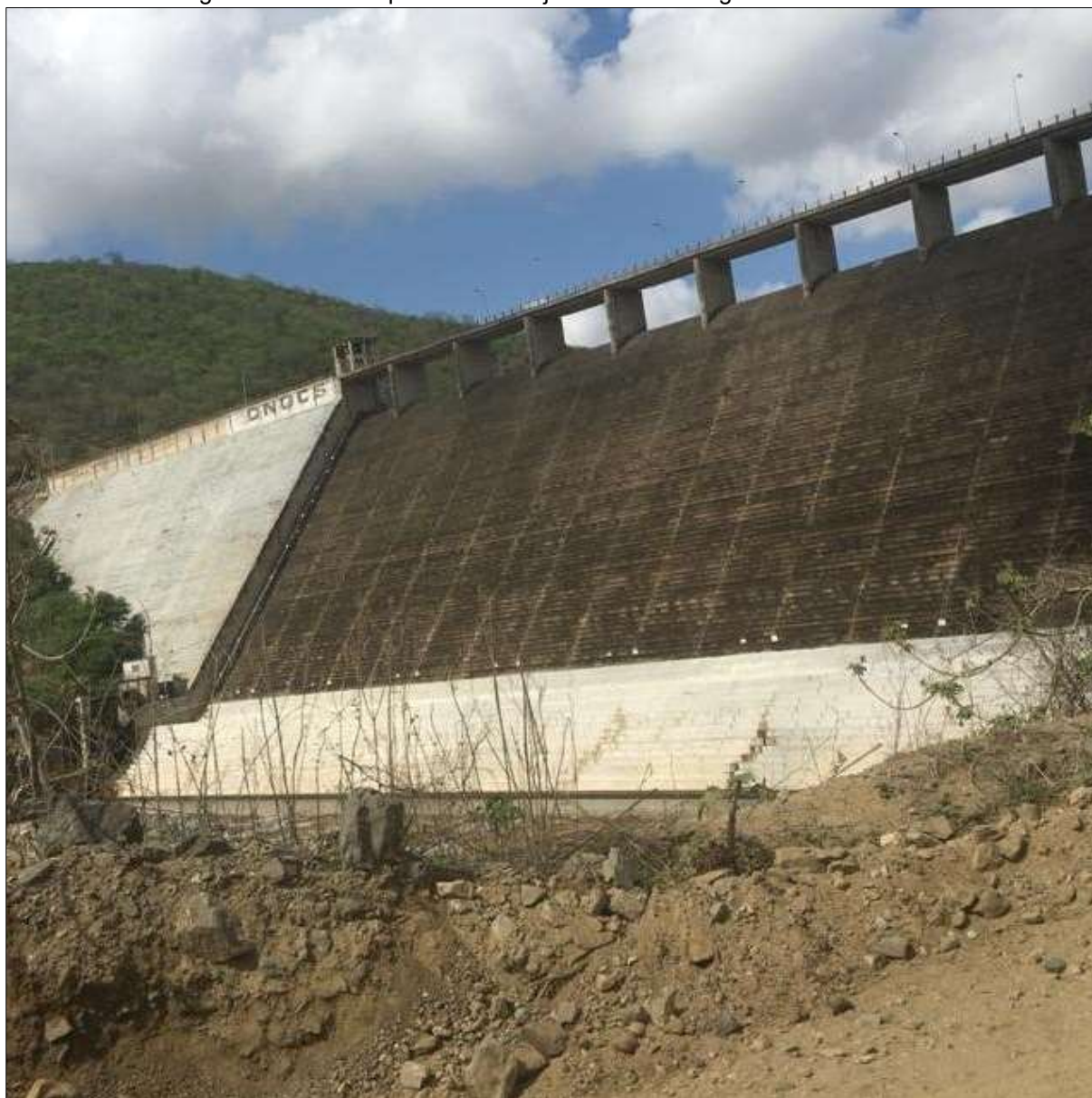
Figura 5 – Vista do paramento de jusante da barragem de Jucazinho.
