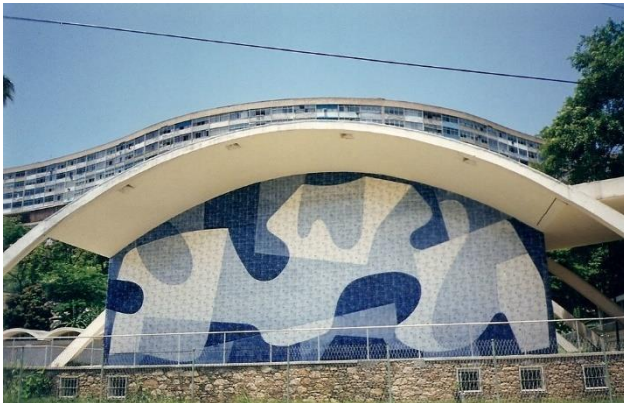
Figura 88: Paineis de Candido Portinari para Escola no Conj. Habitacional de Pedregulho.
